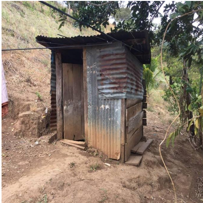
Imagen 1. Fosa séptica de vivienda en caserío El Sitio, Santa Isabel Ishuatán
