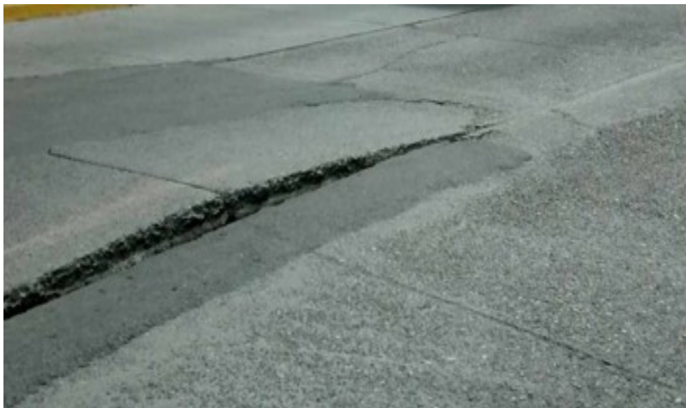
Figura 2.15 Levantamiento de losas en calle Pérez Escobosa, México. (Periódico local mexicano).
