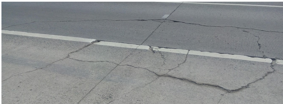
Figura 2.12 Losas Subdivididas Interconexión tramo II.
