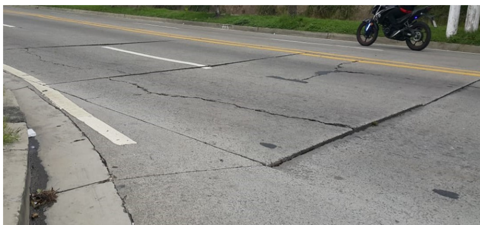
Figura 2.16 Escalonamiento de Losas, 50 Av. Norte, San Salvador.
