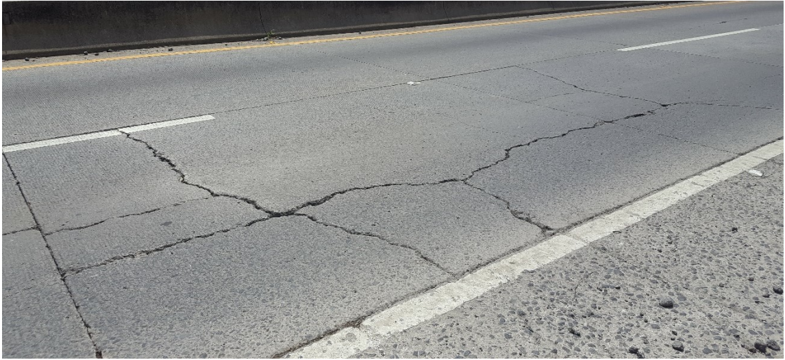
Figura 4.12 Fragmentación múltiple. Interconexión tramo I. San Salvador.
