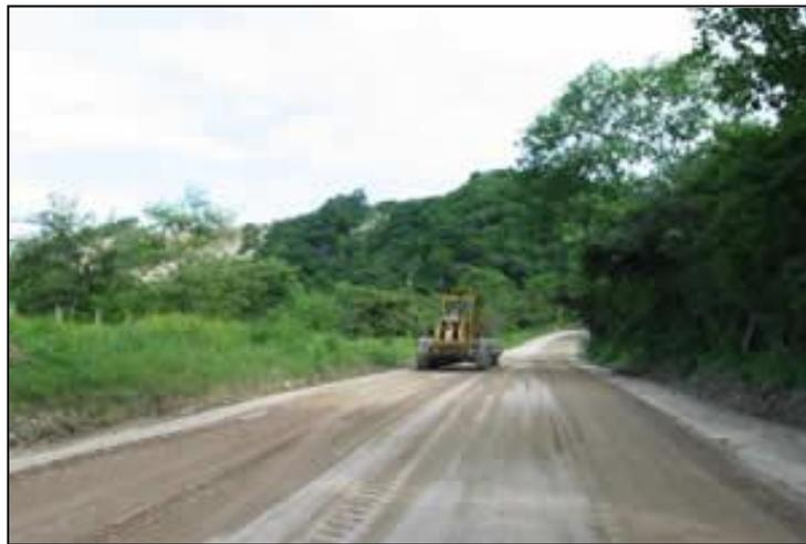
**FIGURA 2.28.** Preparación de la superficie para colocación de CCP
