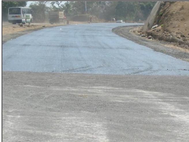
**FIGURA 2.39.** Curado del concreto a través de un mezcla bituminosa
