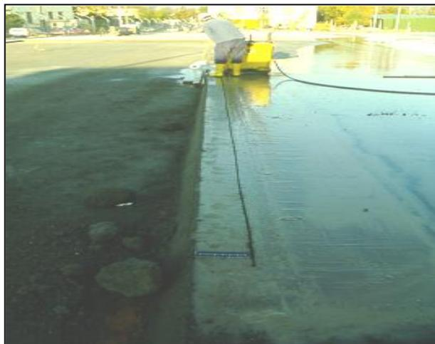
**FIGURA 2.37.** Vista de Junta longitudinal en el pavimento
