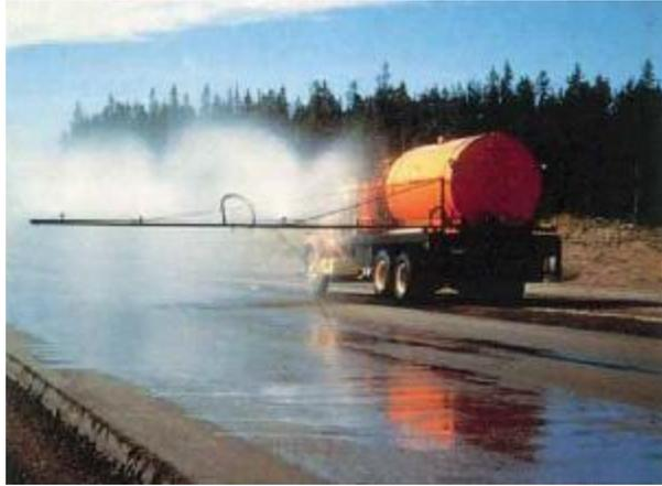
**FIGURA 2.40.** Curado del concreto a través de una rociadora.
