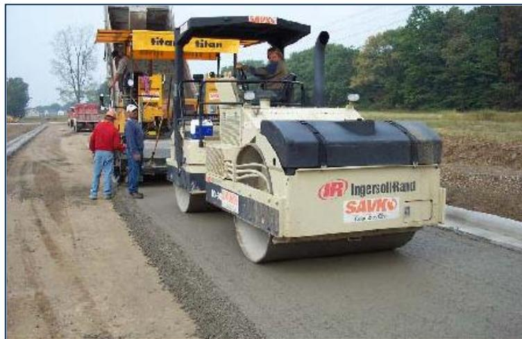
**FIGURA 2.11** Construcción de Pavimento de CCR.
