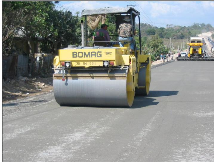
**FIGURA 2.34.** Equipo de compactación rodillo liso sin vibración.
