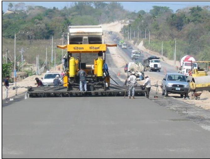
**FIGURA 2.32.** Equipo utilizado para la distribución, conformación y compactación del pavimento
