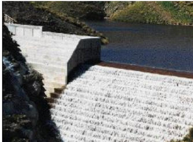
**FIGURA 2.10** Presa construida con CCR en Nueva Zelanda.
