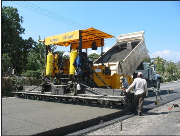
**FIGURA 2.30.** Transporte y colocación del concreto.
