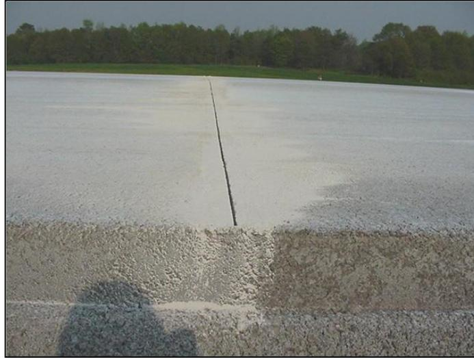
**FIGURA 2.36.** Vista de Junta Transversal en el pavimento.
