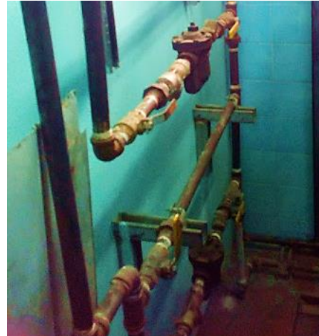
Ilustración 3.8: Tubería de inyección de vapor a secadoras, ubicadas en el área de lavandería del HNZ.
