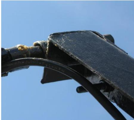
**Figura C.5** Extremo norte que muestra los pernos de la chumacera removible.
