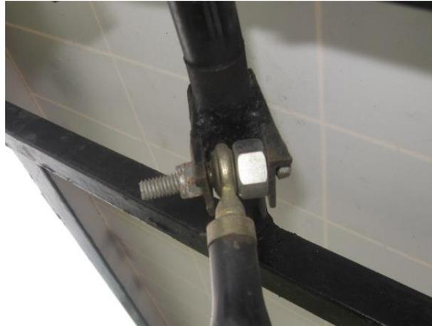
**Figura C.4** Unión de brazo mecánico con marco del panel
