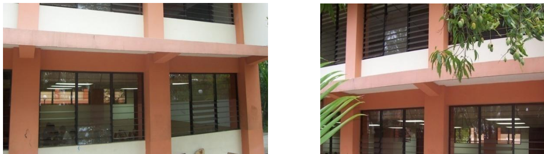
Figura 14. Observación del Edificio aulas C, el cual se dejar ver como existe una mala utilización del sistema de iluminación.
