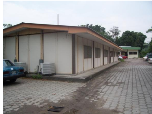
Instalaciones de CIAN
