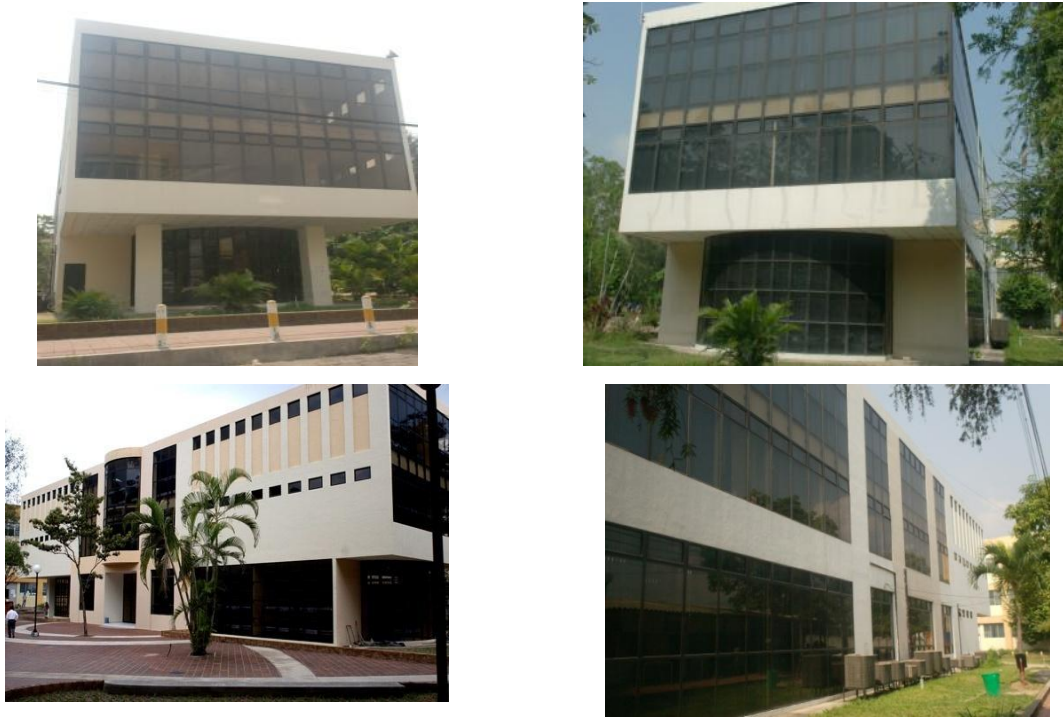
Figura 8. Diferentes vistas del edificio de Administración Académica de la FIA.
