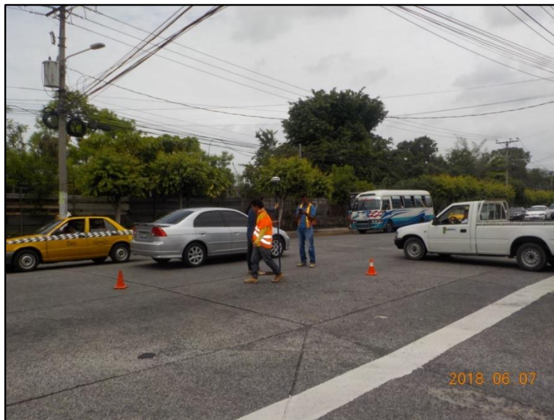
Figura 3.16. Toma de coordenada en pozo sobre la prolongación del Blvd.
