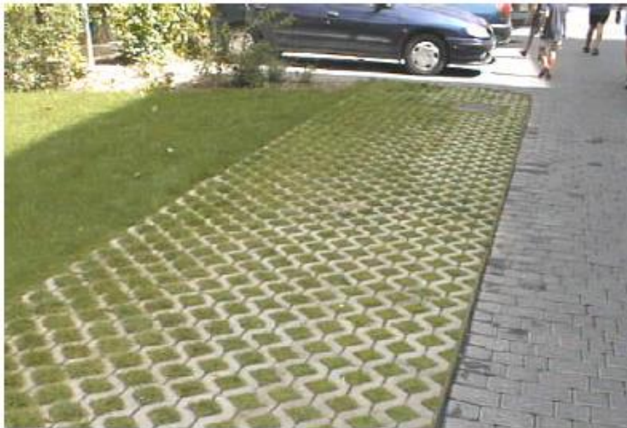
Figura 5.4. Pavimento filtrante en áreas de parqueos.
