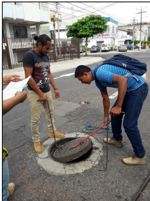
Figura 3.22. Levantamiento de tapadera de pozo de visita.
