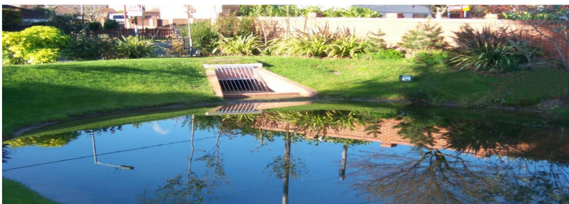
Figura 5.5. Depósito de detención en superficie.
