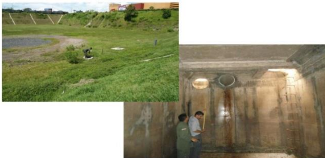
Figura 5.6. Sistema de retención enterrado, Torre El Pedregal, Contiguo a Multiplaza.
