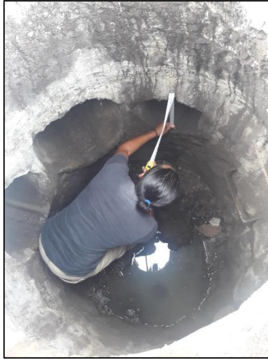
Figura 3.25. Toma de diámetro de tuberías de pozo de visita.
