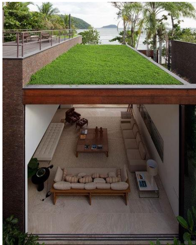
Figura 5.1. Techo verde ubicado en el segundo nivel de una vivienda.
