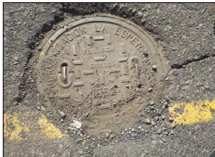
Figura 3.4. Tapaderas de pozos de visita parcialmente sellada por carpeta asfáltica. Fuente: Elaboración Propia.
