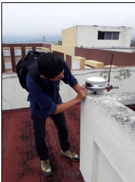
Figura 3.7. Colocación de GPS (Base) en azotea del edificio de Medicina, UES.
