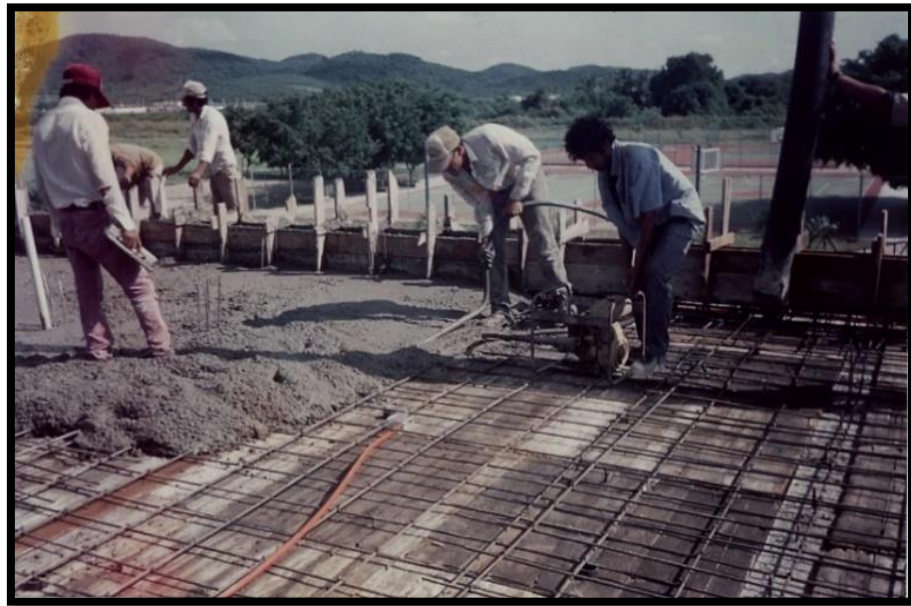
Figura 2.7: Colado de losa de concreto.
