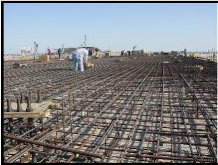
Figura 2.41: Parrilla de acero de refuerzo. Fuente http://estructuras-de-concreto.blogspot.com/
