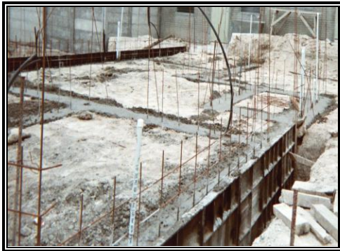
Figura 2.42: Colado de Soleras de Fundación.
