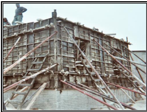
Figura 2.45: Alineamiento del Molde.
