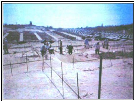
Figura 2.38: Trazo y Colocación de Niveletas.
