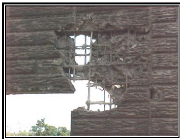
Figura 2.59: Concreto sin Fluidez Tomada de Revista ISCYC.
