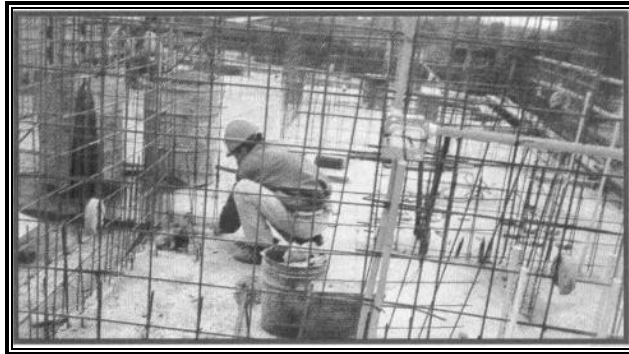
Figura 2.54: Colocación de la Electromalla. Tomado de Manual de Forza.
