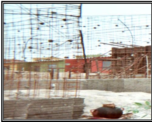
Figura 2.44: Armadura de Paredes.
