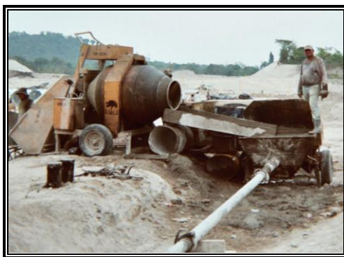
Figura 2.47: Equipo Utilizado en el Colado de las Viviendas.
