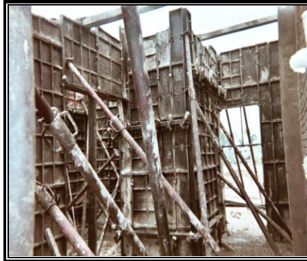
Figura 2.46: Molde a Plomo.
