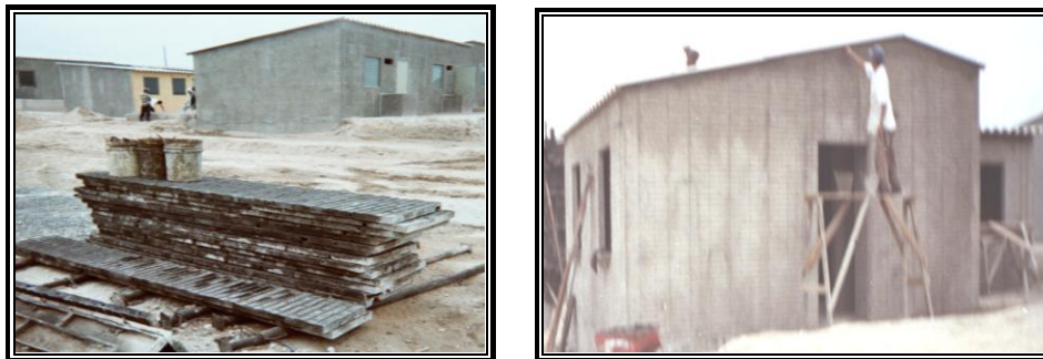
Figura 2.50: Curado y Resane en Paredes Terminadas.
