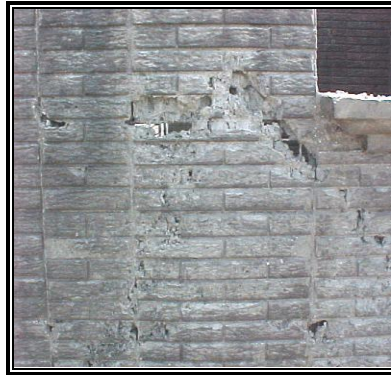
Figura 2.58: Consolidación Deficiente Tomada de Revista ISCYC.
