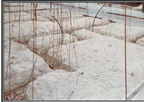
Figura 2.39: Excavación para Soleras de Fundación y Muretes.
