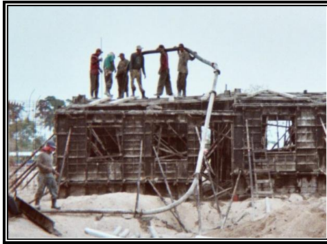
Figura 2.48: Colado de la Vivienda.
