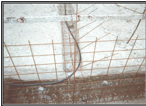
Figura 2.40: Armaduría de Fundaciones.
