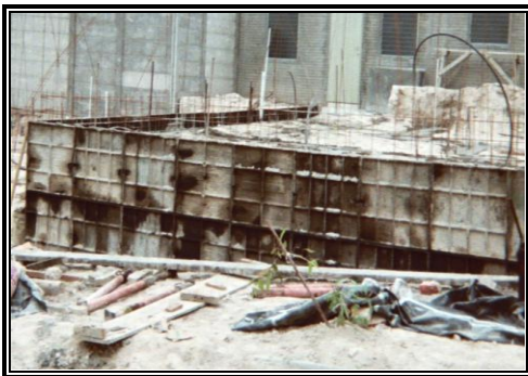
Figura 2.43: Colado de Muretes.
