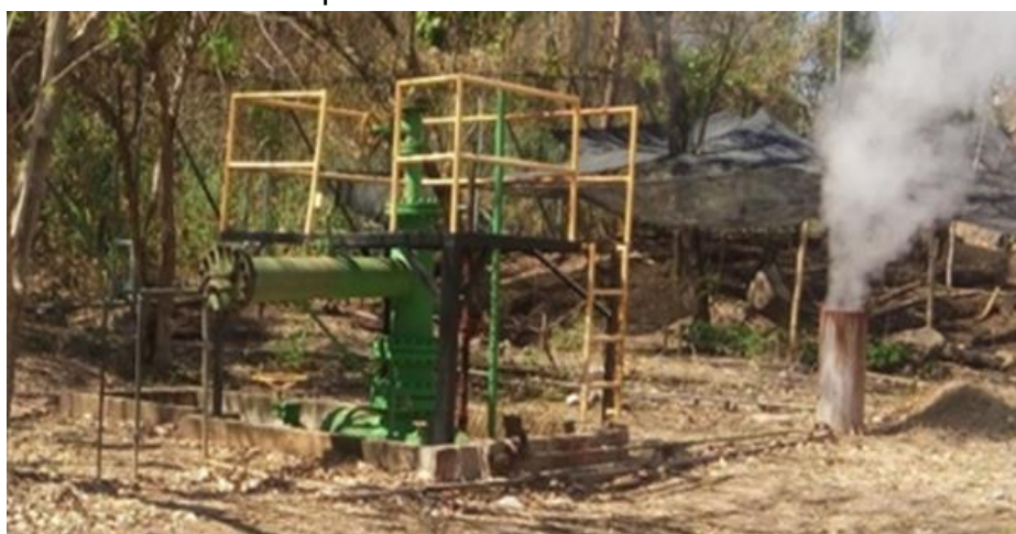
Figura 4. Vista de un pozo en observación. [Fotografía].
