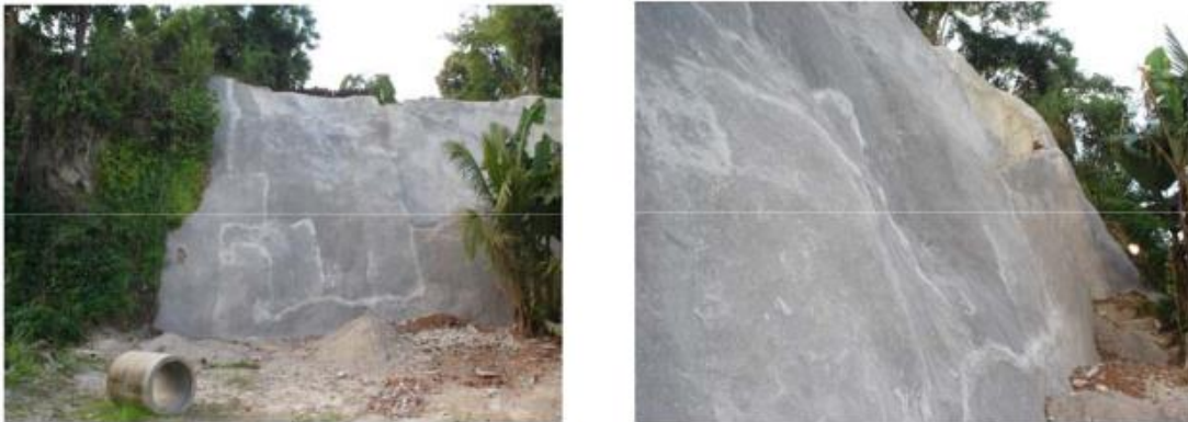
Ilustración 100: Recubrimiento de Talud
