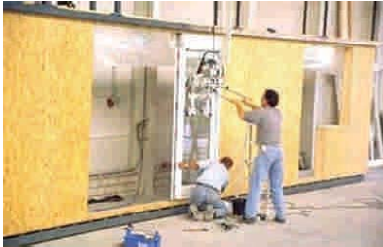
Figura 2.16. Instalación de una puerta a un tabique autoportante.
