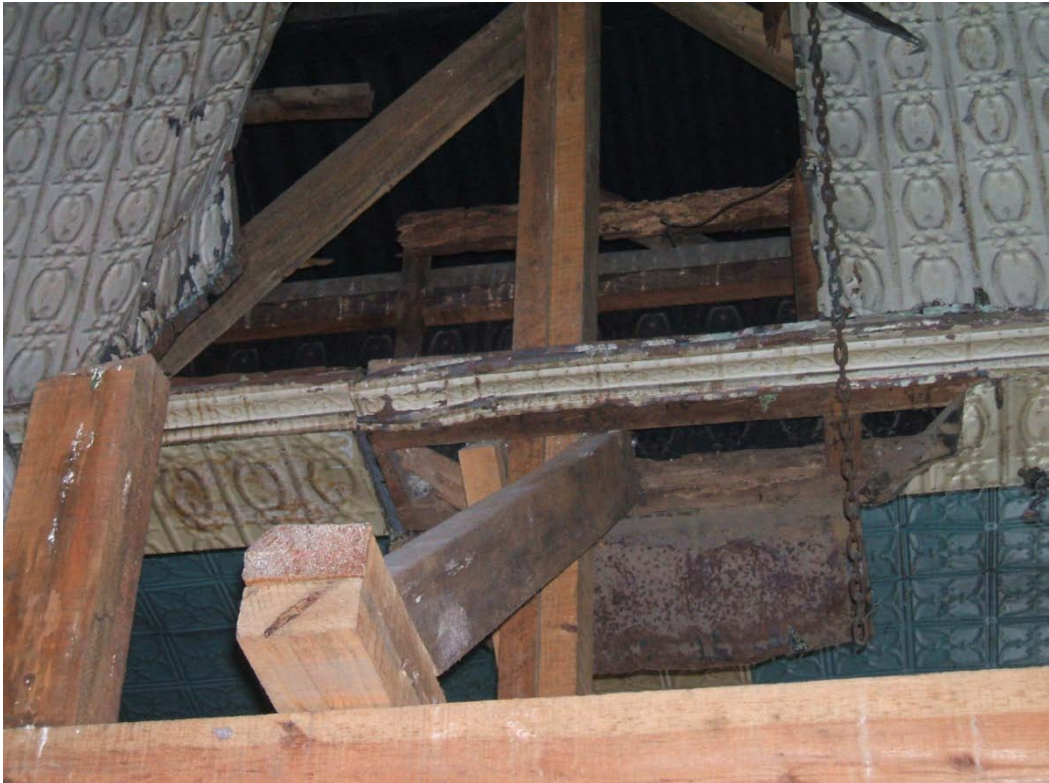
Apuntalamiento de vigas longitudinales de madera, cimbrado de madera de pino.
