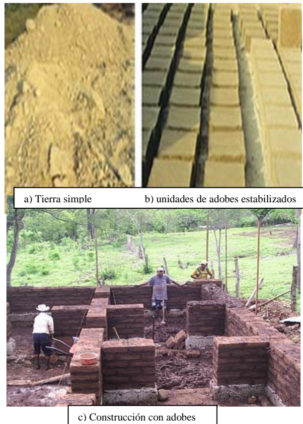
Figura 2.20. Elaboración y uso moderno del adobe estabilizado.
