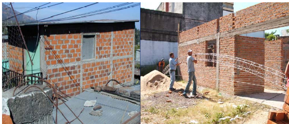
Figura 2.23: Edificación de Mampostería de Ladrillo de barro, Sistema estructural y sistema constructivo mixto.
