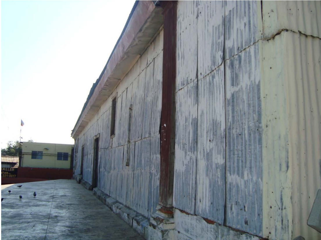
Fachada Norte del perímetro de la iglesia murete o sobrefundación, paredes y ático del techo. Plazuela moderna.
