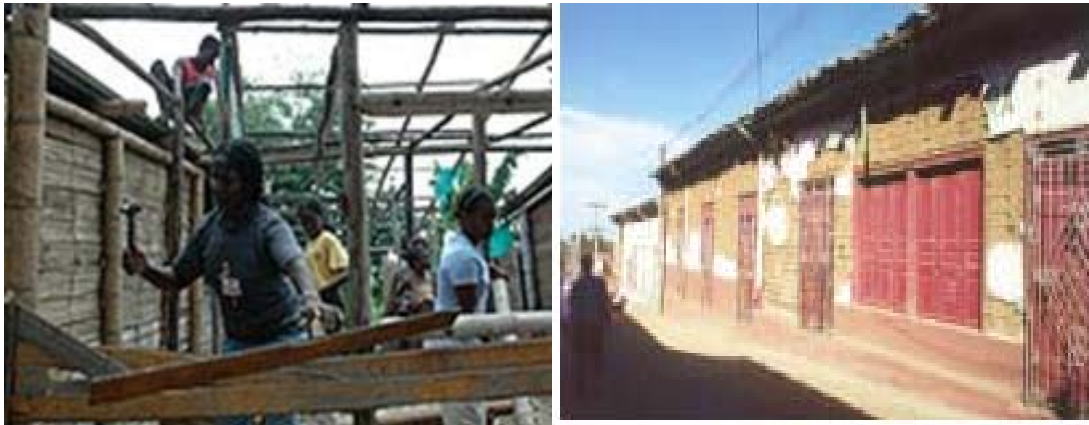
a) Construcción madera con bahareque
