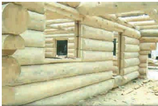
Figura 2.14. Vivienda construida con troncos macizos, de diámetro promedio de 30 a 35 cm.
