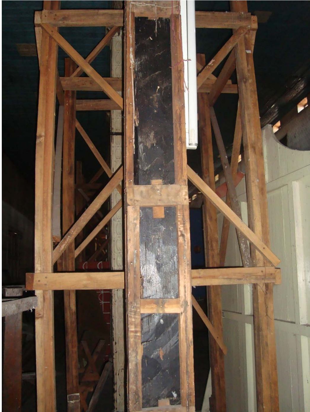
Detalle de columna con apuntalamientos, cimbrado de madera de pino.
