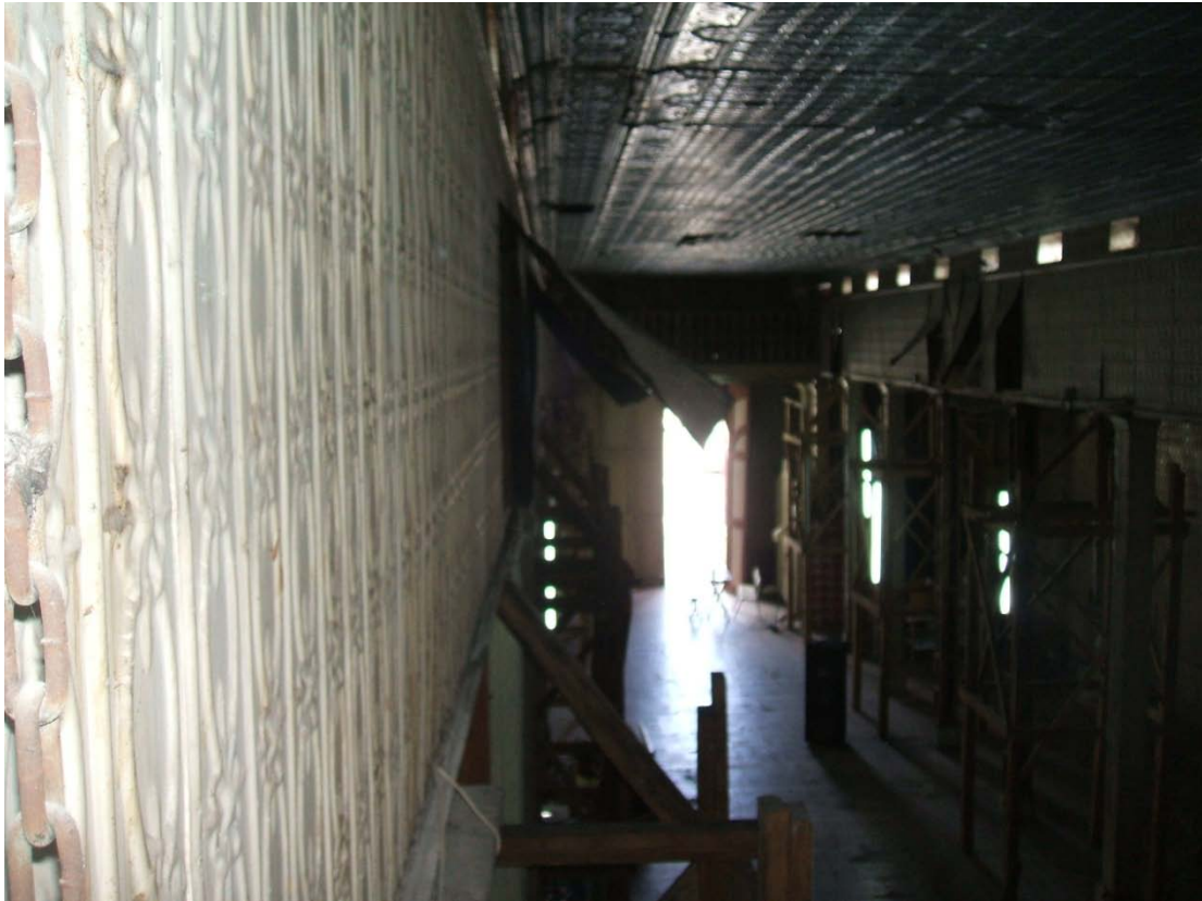
Vista superior de estructura de cielo falso de iglesia San Esteban.
