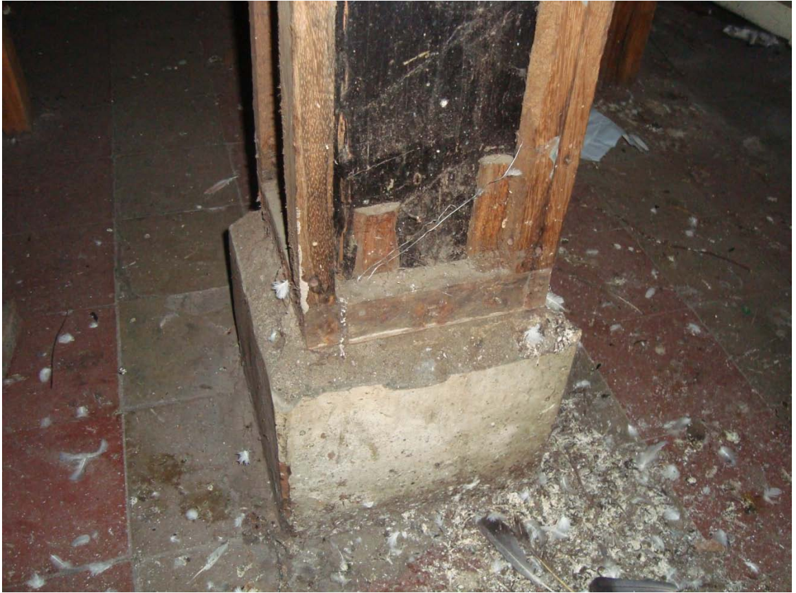
Detalle de pilastra, estructura principal de la nave.
