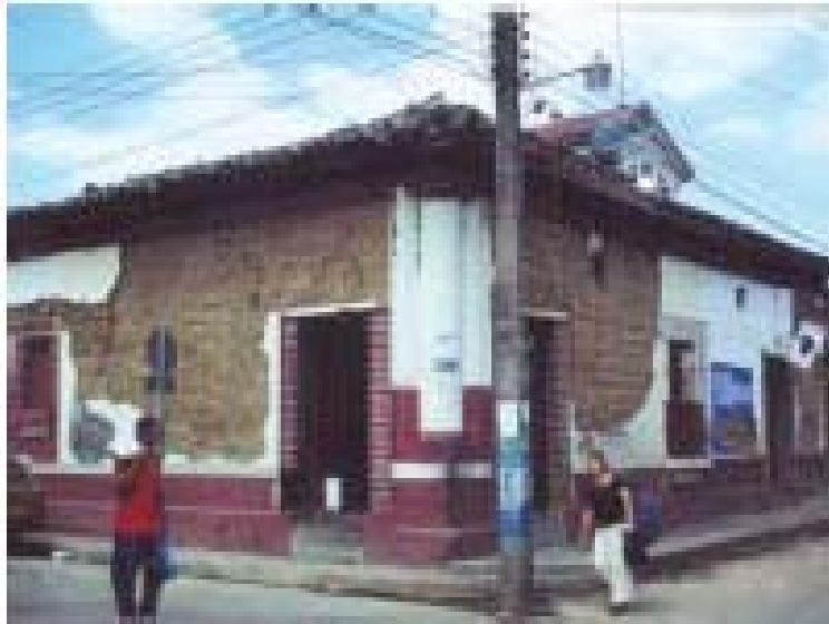
Figura 2.19. Vivienda de adobe.
