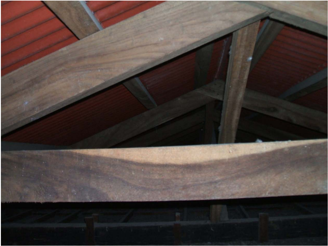
Estructura de techo reconstruida.
