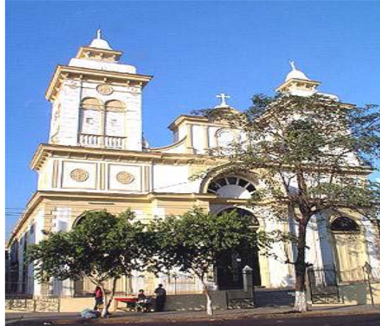
Figura 2.22. Edificaciones de Lámina Troquelada, Iglesia El Carmen, San Salvador.
