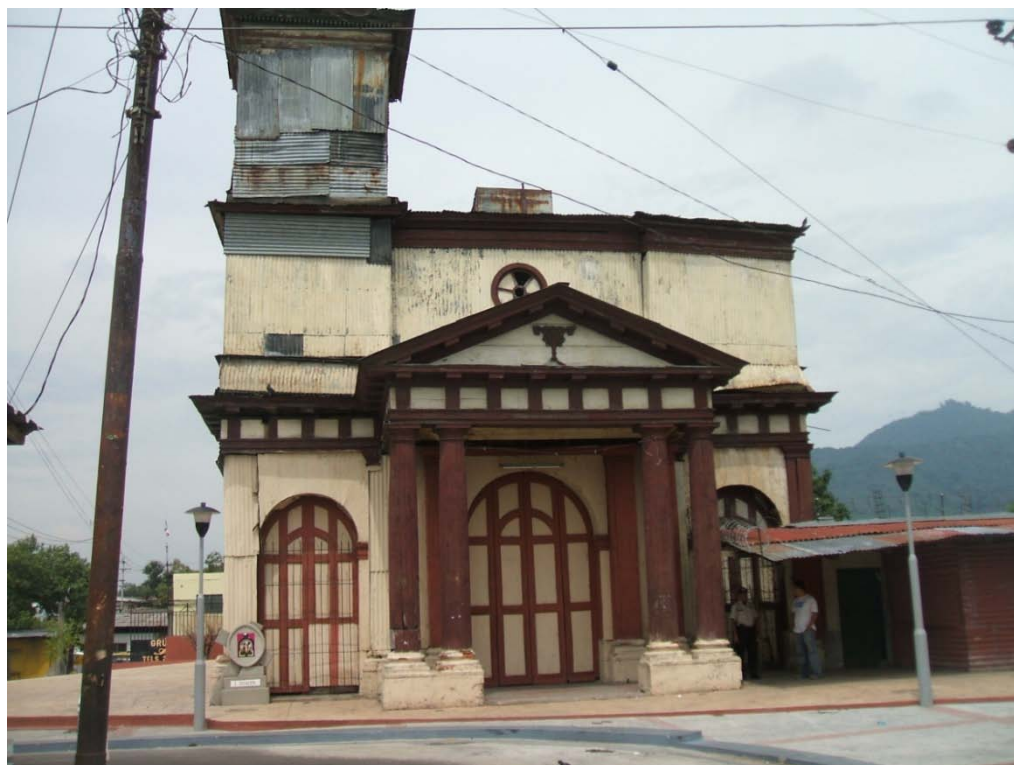
Fig. 4.1 Fachada poniente actual de la Iglesia San Esteban.
