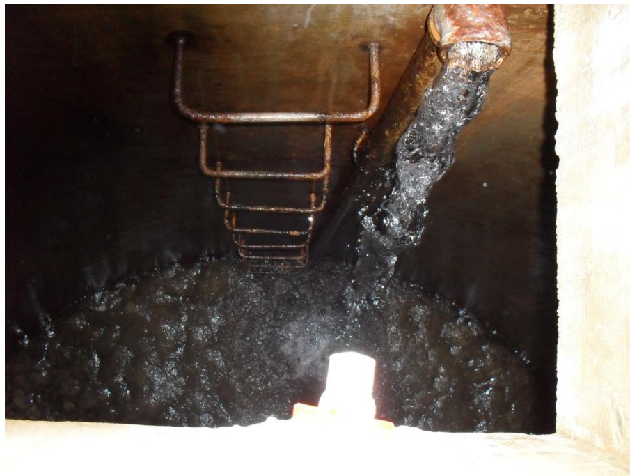
FOTO 6. VISTA INTERIOR DEL TANQUE.
