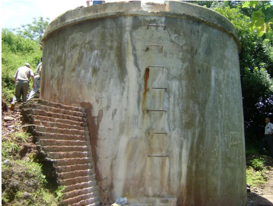
FOTO 5. TANQUE EXISTENTE DE 100 m 3 DE CAPACIDAD.
