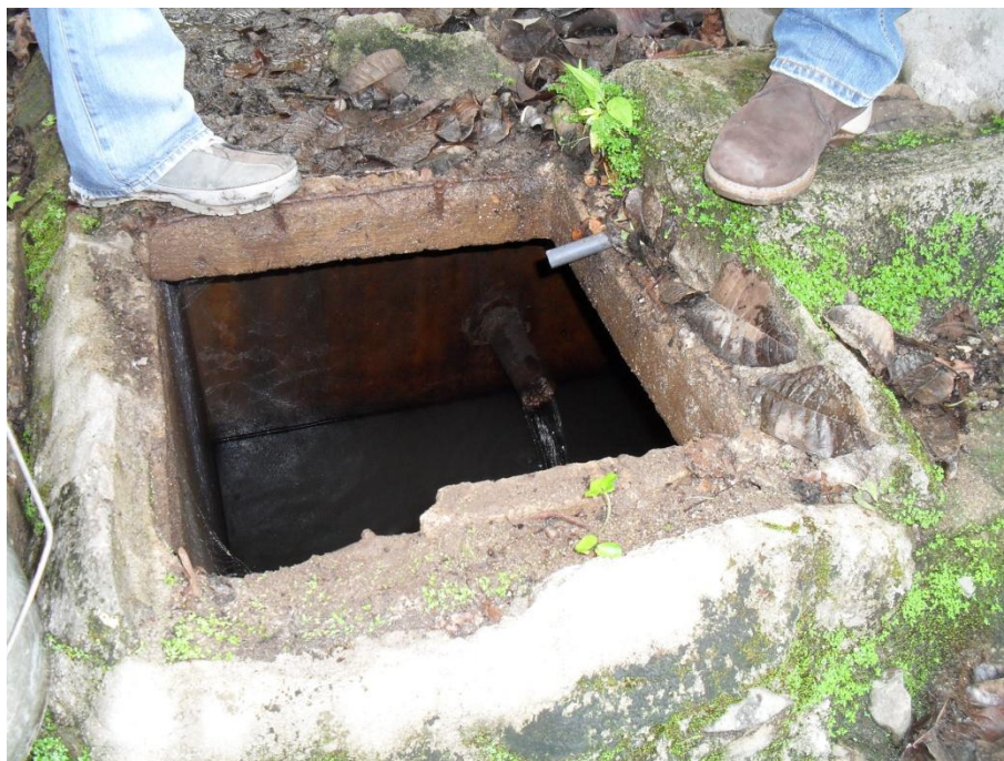
FOTO 2. CAJA DE VISITA DE CAPTACIÓN EXISTENTE
