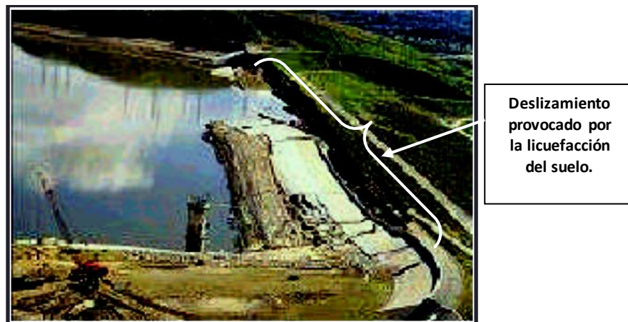
Figura 2.8 Deslizamiento en la presa de San Fernando, terremoto de 1971.
