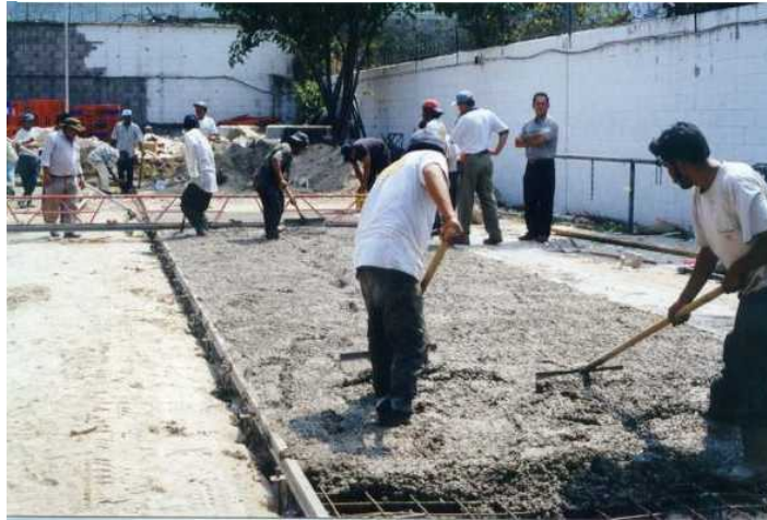
Fig. 3.28. Descarga y Distribución del Concreto.
