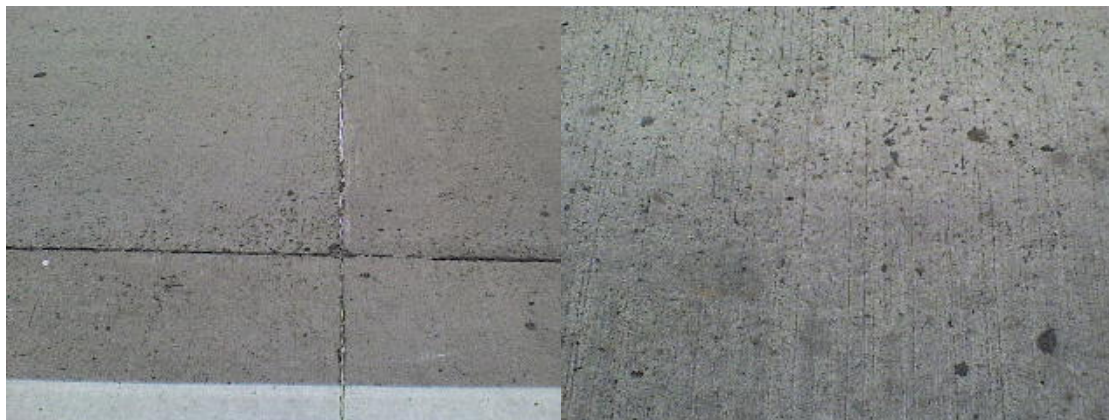
Figuras 5.34 a y b. Pulimiento. (Tomadas en 9na. Calle Poniente de Santa Tecla)
