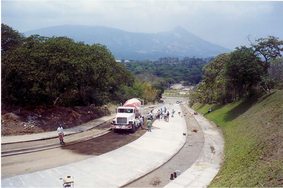
Figura 2.11. Fotografía de la Construcción de un Pavimento Rígido.
