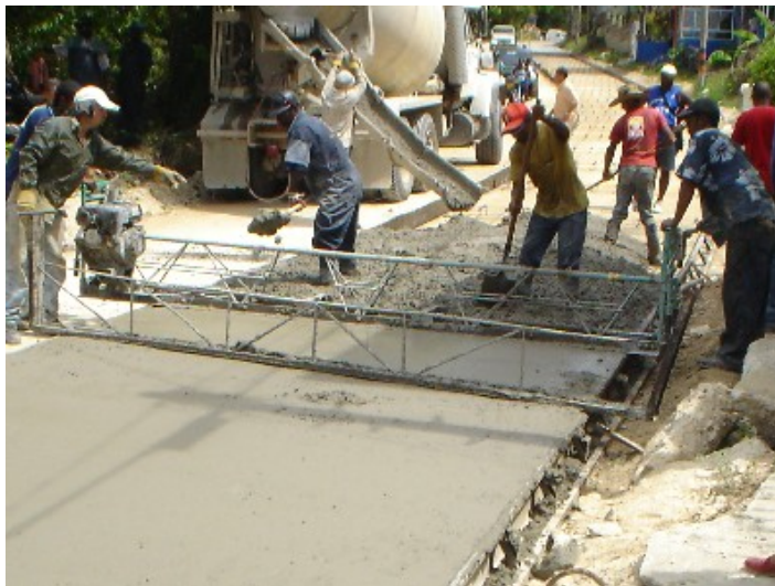
Fig. 3.43. Reglas vibratorias.
