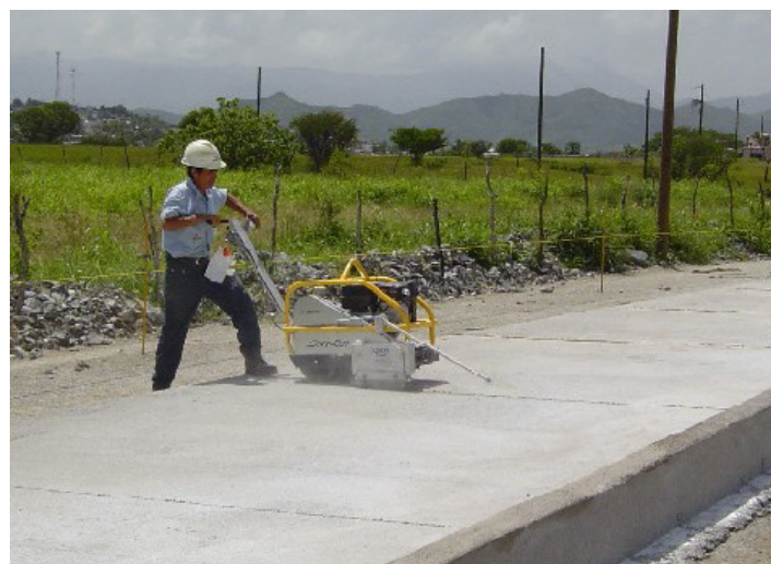
Fig. 3.34. Aserrado de las Juntas.
