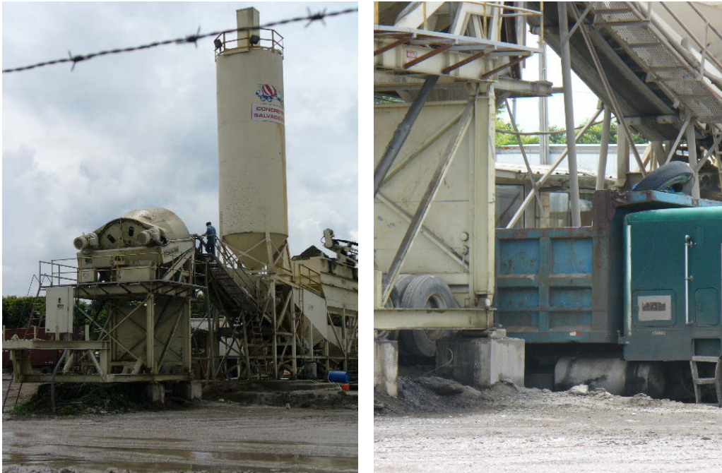
Figs. 3.26 y 3.27. Planta móvil para Mezclas de Concreto.
