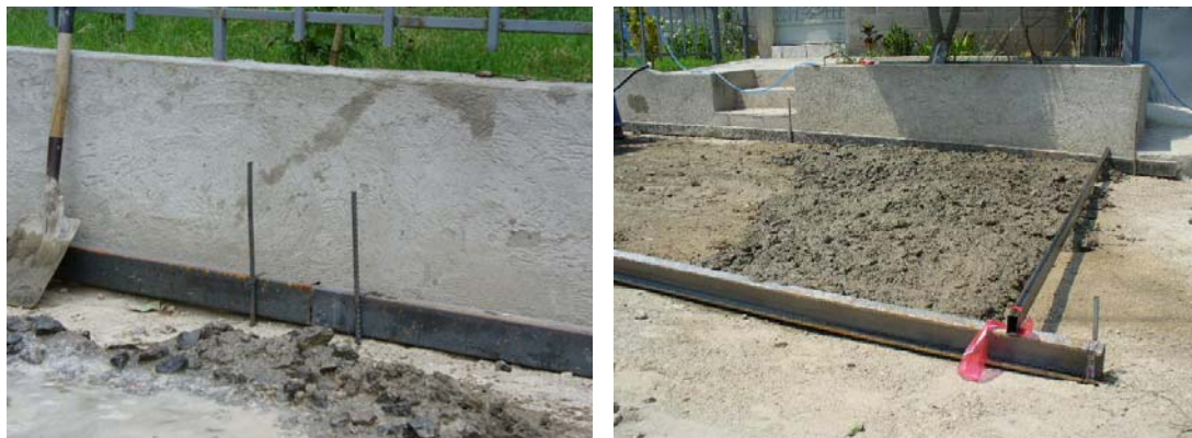
Figs. 3.41 y 3.42. Formaleta para losas.
