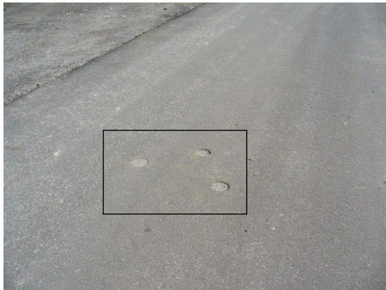
Figura 4.6. Núcleos extraídos del pavimento
