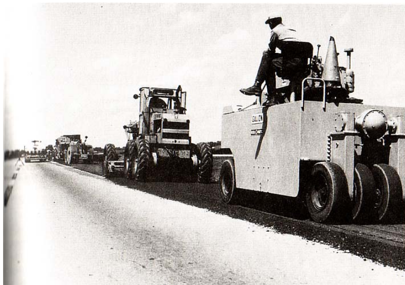
Fig. 3.7 Extendido, seguido de Compactación
