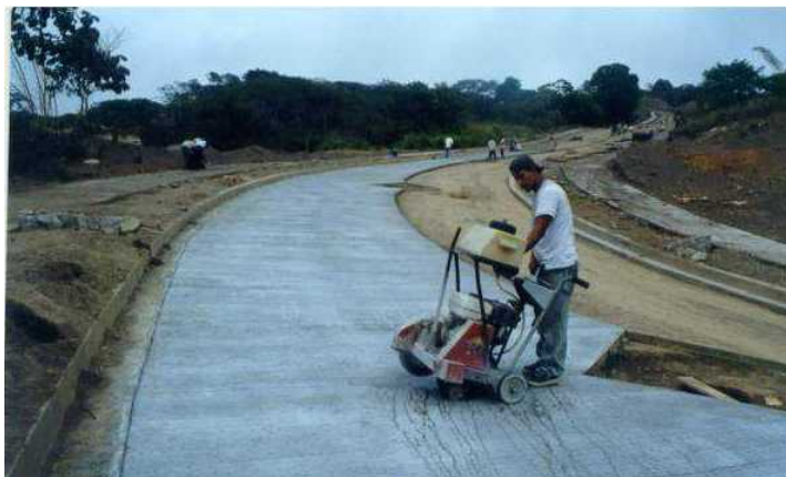
Fig. 3.39. Ejecución de Juntas con Sierra de Disco.
