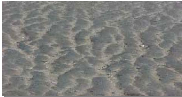
Figura 5.16. Corrimiento (Fuente: Catalogo de Daños SIECA)
