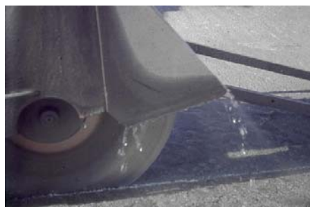
Figs. 3.48 y 3.49. Máquina cortadora de concreto para el aserrado de las Juntas.
