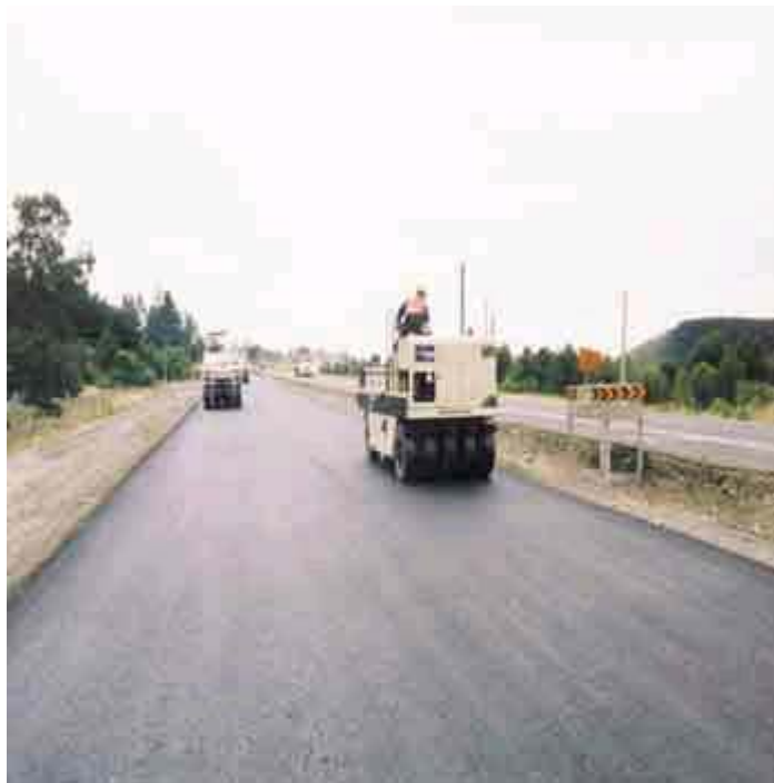
Fig. 3.6 Compactación con Rodillo Neumático
