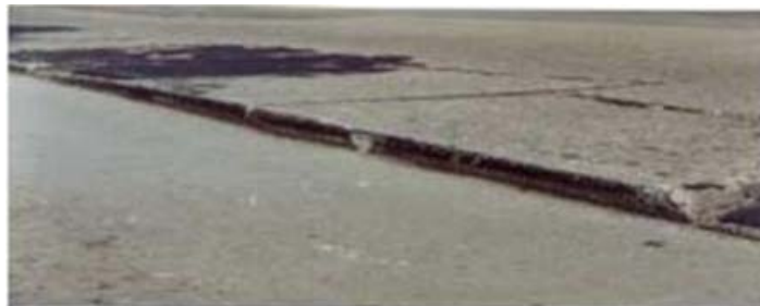
Figura 5.31. Dislocamiento. (Fuente: Catálogo de Daños de SIECA)
