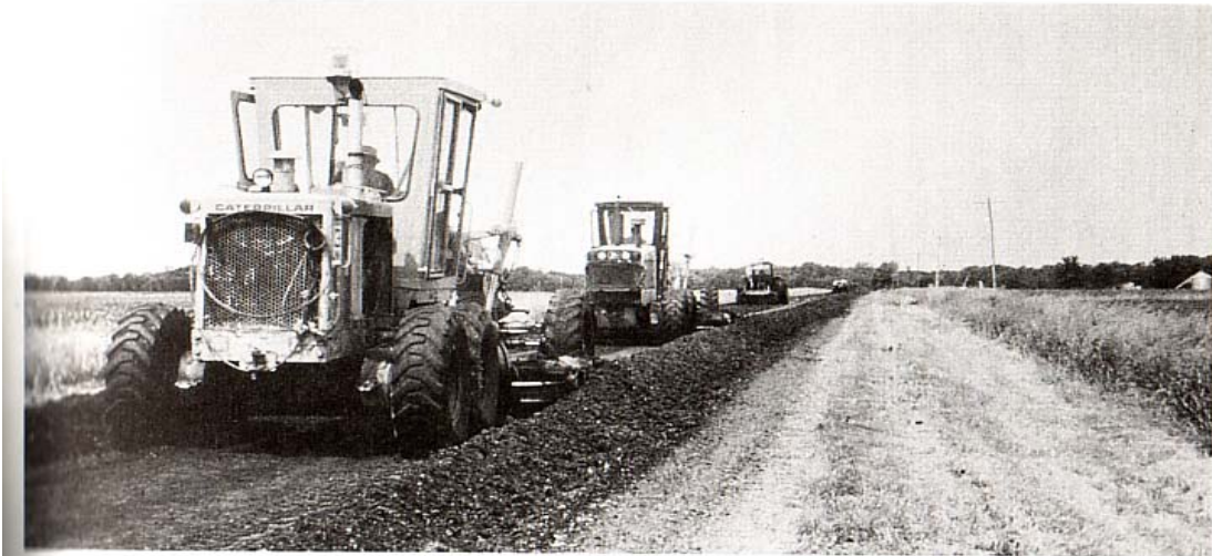
Fig. 3.5 Extensión de la Mezcla
