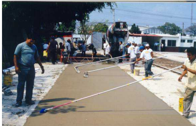
Fig. 3.45. Terminado o Acabado.
