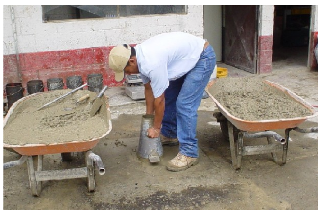
Figura 4.9. Prueba de Revenimiento en Obra.
