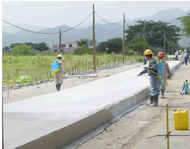
Fig. 3.30. Curado químico del Pavimento de Concreto.
