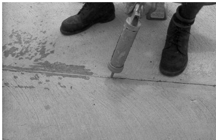
Fig. 3.40. Sellado de las Juntas.
