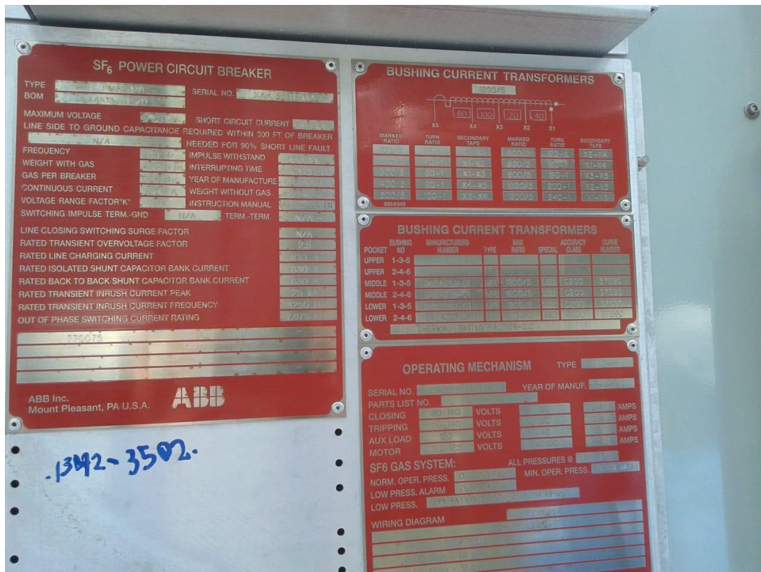
Placa de datos técnicos Interruptor SF6 ABB
