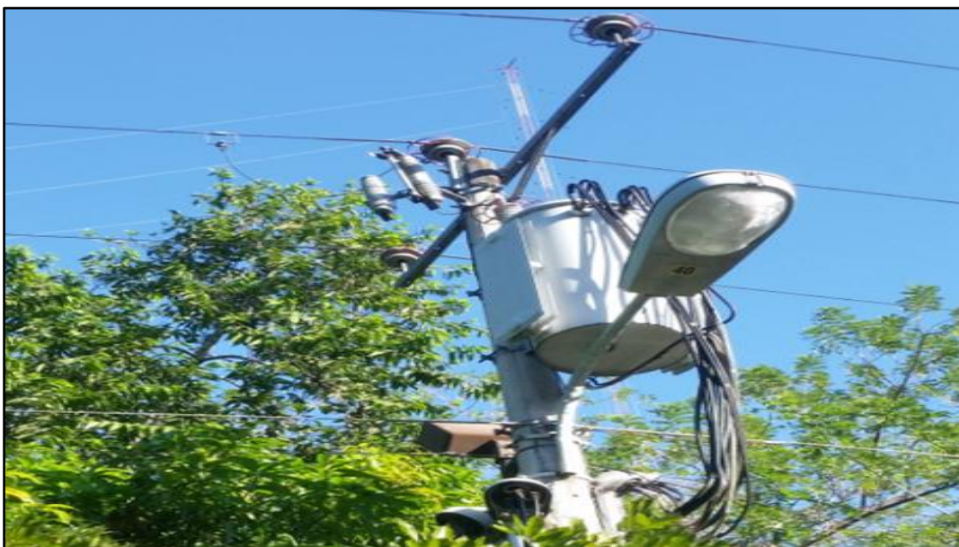
Figura 101. Transformador monofásico de 75 kVA para laboratorios de biología
