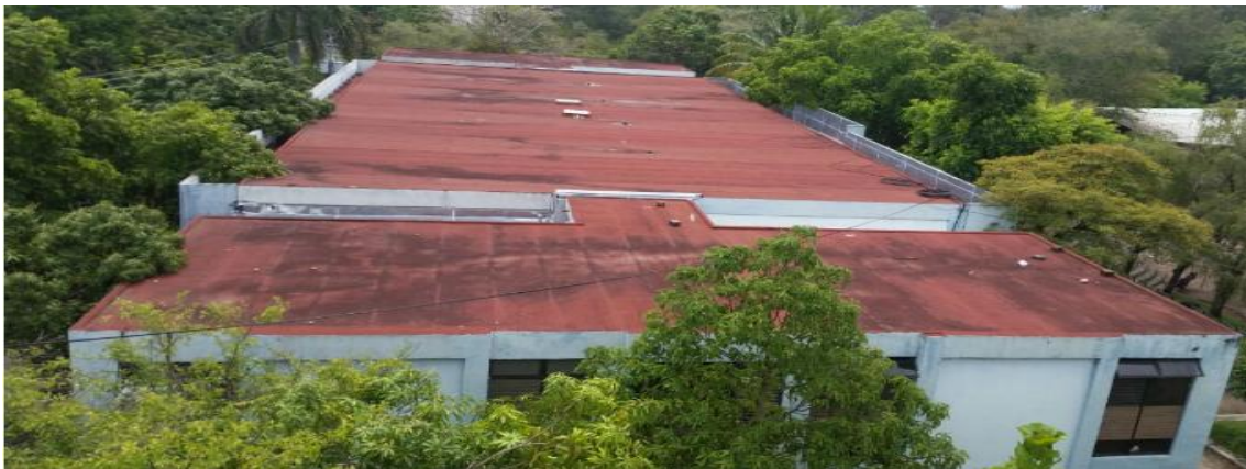
Figura 17. Techo correspondiente al edificio de periodismo y letras.
