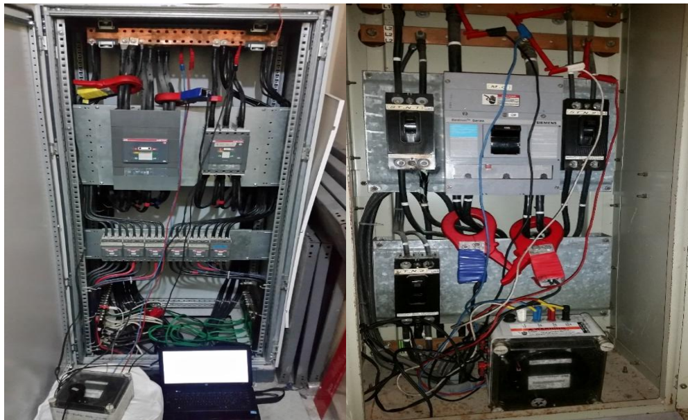
Figura 63. Ilustración de la conexión trifásica y monofásica para el medidor ALPHA Power
