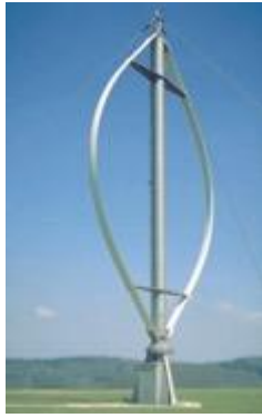
Ilustración 1.18: Aerogenerador tipo Darrieus.
