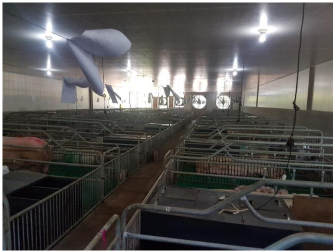
Anexo A- 3. Galera climatizada.
