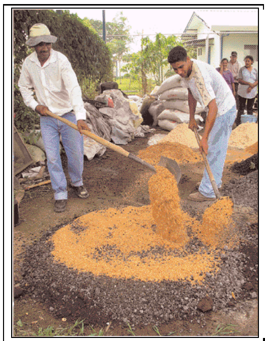
Fig. D-2 realización de promontorio en capas con los materiales de la primera fila.
