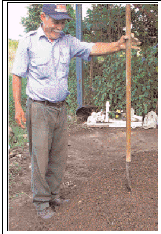
Fig.D-6 Extendido de la mezcla.
