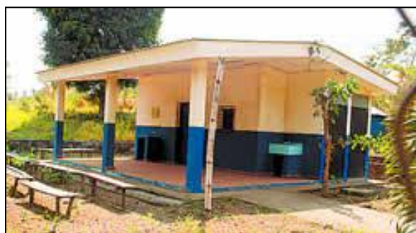
Un edificio casi decorativo. La casa de salud, en el cantón Cuzamaluco, está cerrada desde que se terminó en 2003.
