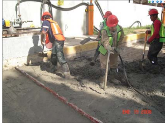
Fotografías 5.13 Realización de colado de concreto.
