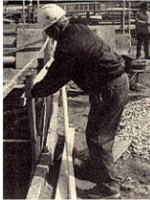
Fotografías 5.8 Colocación de baranda de seguridad
