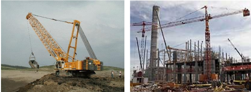
Fotografías 5.4 Grúas transportando carga
