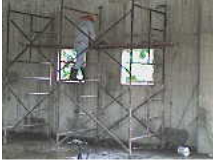
Fotografías 5.2 Andamios tubulares en la construcción
