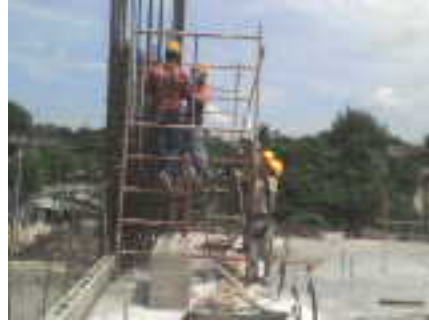
Fotografías 5.2 Andamios tubulares en la construcción
