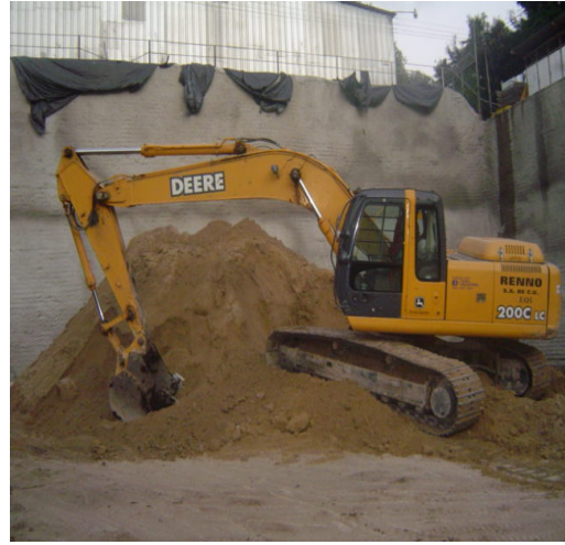
Fotografía 5.5 Pala mecánica en trabajo de excavación y carga
