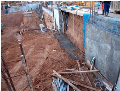
Fotografía 5.10 Muro de protección en excavación Fig. 5.18 Zanja protegida correctamente
