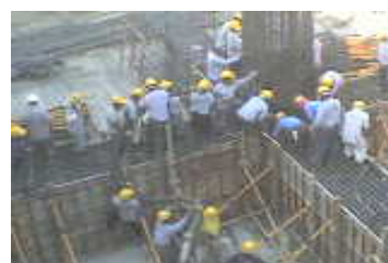
Fotografías 5.12 Encofrados metálicos en la construcción.
