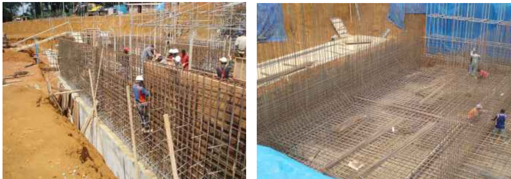
Fotografías 5.11 Armaduría de muro y losa de fundación.
