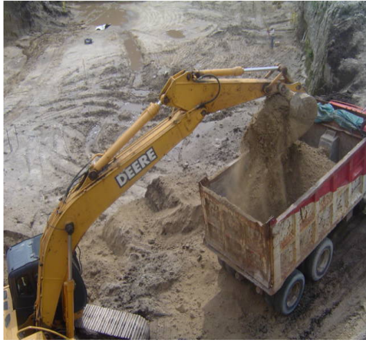
Fotografía 5.5 Pala mecánica en trabajo de excavación y carga
