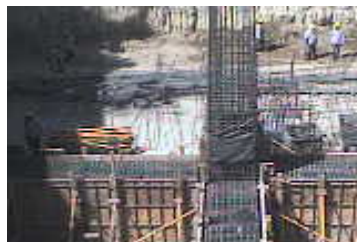
Fotografías 5.12 Encofrados metálicos en la construcción.
