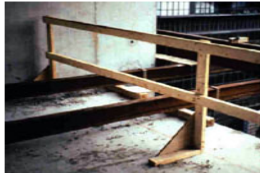
Fotografías 5.8 Colocación de baranda de seguridad
