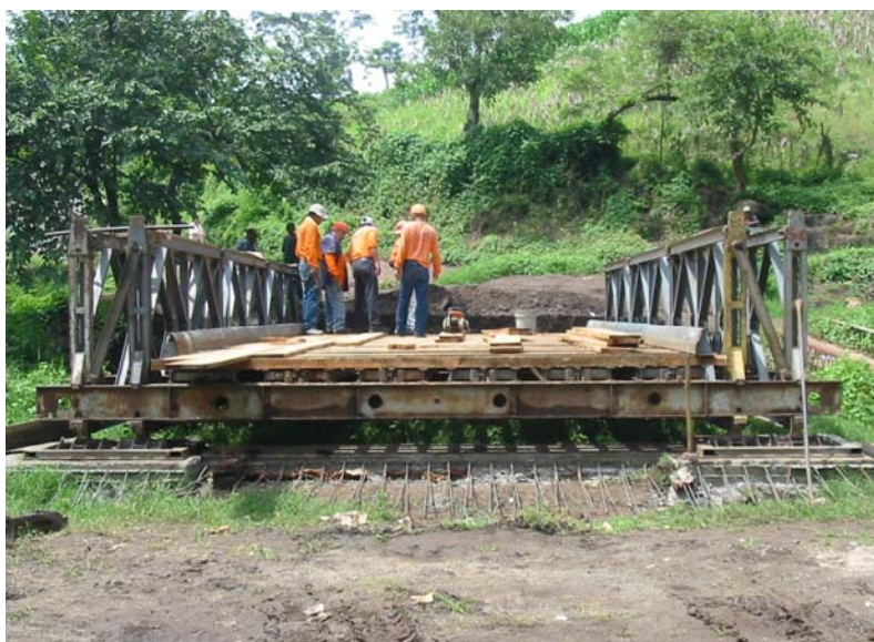
Figura 3.7 Estribo de concreto para puentes metálicos modulares, con las varillas vistas del cabezal de estribo vertical, para el lanzamiento del puente y posterior colado.
