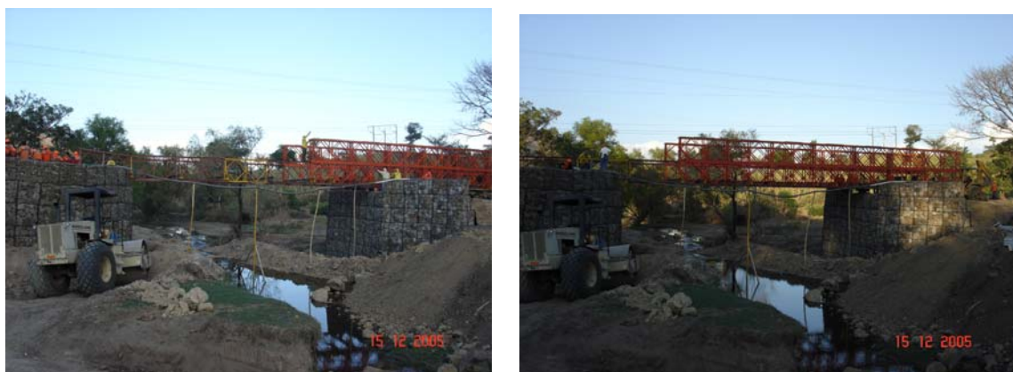
Figura 4.35 Lanzamiento de puente Bailey D.D.70' M-2. Presa Cerrón Grande.
