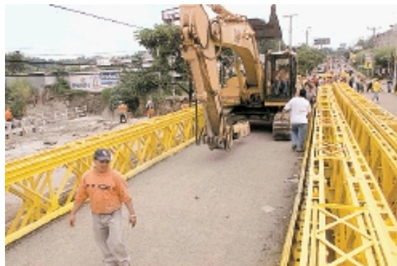
Figura 4.41 Puentes Bailey TSR 100' M-2 en el Boulevard del Ejercito, probando su resistencia con una carga de 35 toneladas.
