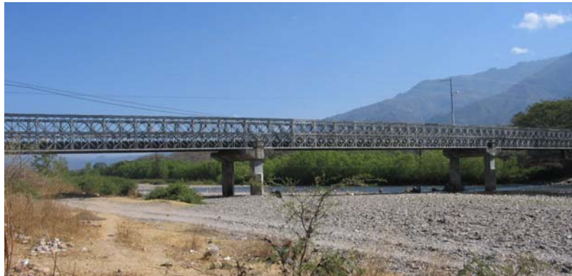
Figura 5.20 Puente Acrow Panel, Citalá, TDM - 430', Chalatenango.
