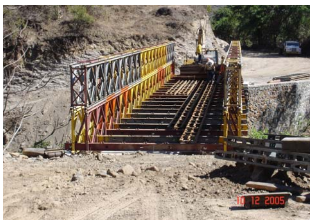
Figura 4.37 Montaje de emparrillados planos y de botones.
