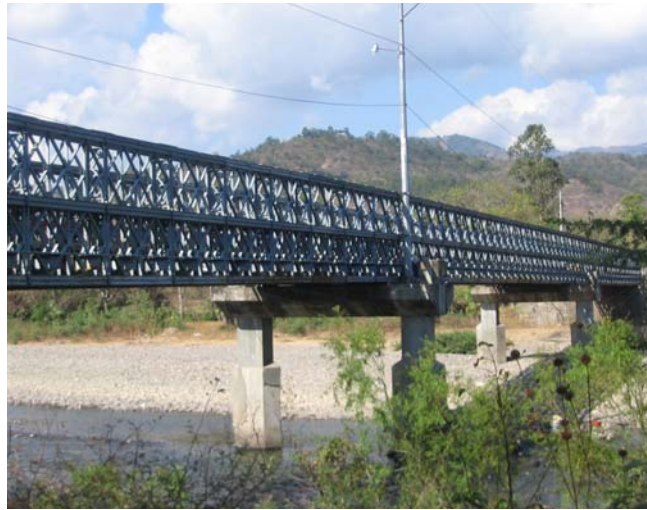
Figura 1.11 Pila tipo marco, puente Acrow, Triple Doble 430' Cítala. Chalatenango.
