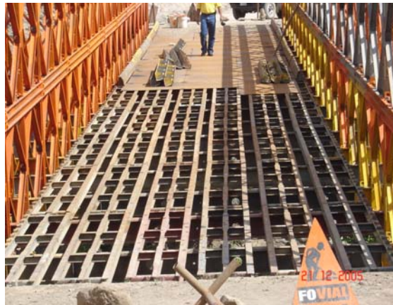
Figura 4.39 Montaje de calzada de acero.
