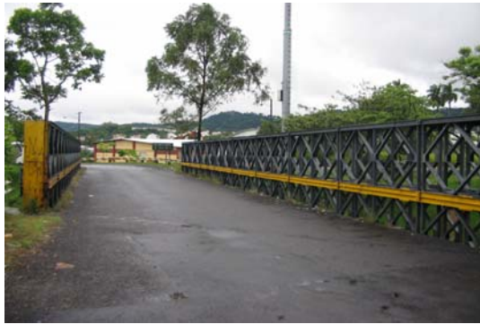
c) Calzada de pavimento asfáltico.
