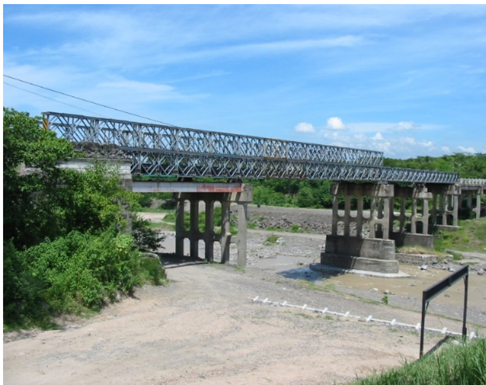
Figura 1.6 Puente provisional Bailey sobre el río Jiboa, departamento de La Paz.
