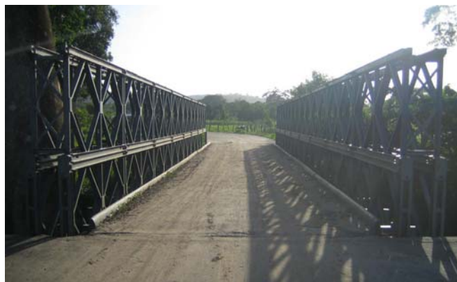
Figura 5.19 Puente Bailey, El Pipil, DD - 80', San Pablo Tacachico.
