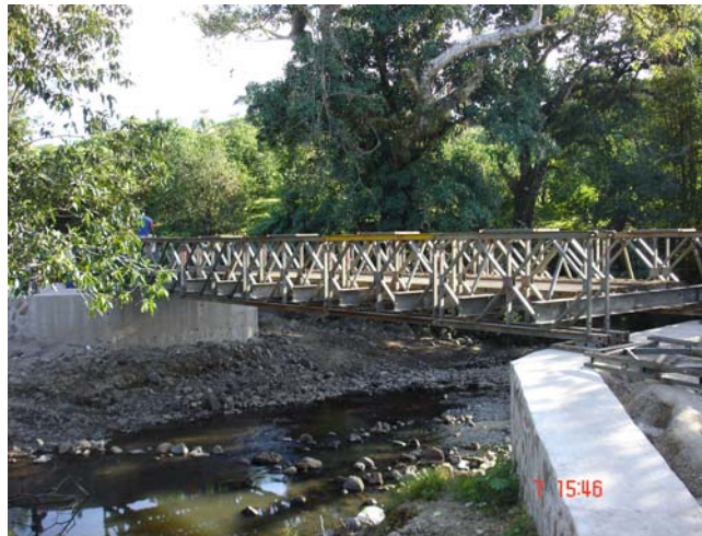
Figura 1.12 Estribo de mampostería, con aletones, puente Acrow Doble Simple 60' Acrow panel "El Carrizo". Cabañas.
