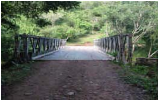
a) Calzada de lámina de acero lagrimada.
