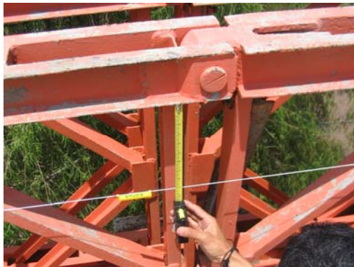
Figura 5.7 Puente Bailey, La Barra, TS - 200', Metapán.
