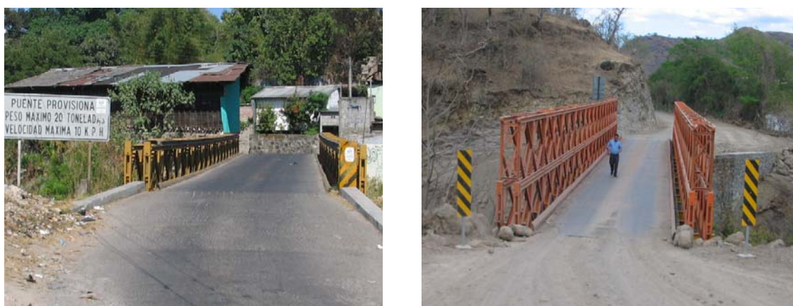
Figura 4.42 Señalización de puentes metálicos modulares.
