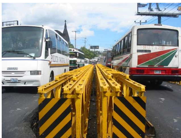
Figura 1.1 Puentes Bailey en el Boulevard del Ejercito sobre el río Acelhuate.
