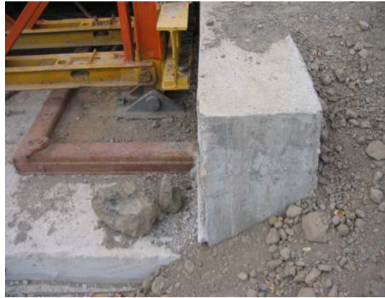
Figura 4.40 Empotramiento de placas de apoyo en cabezal de concreto reforzado.
