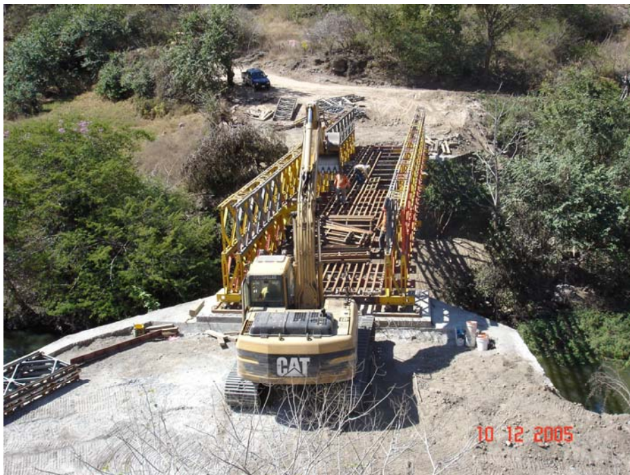
Figura 4.9 Montaje de puente Bailey Doble Doble, de 100 pies, mediante el uso de pala mecánica. Ciudad Dolores, Sensuntepeque.
