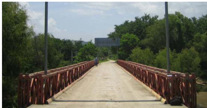
Figura 5.12 Puente Bailey, La Barra, TS - 200', Metapán.
