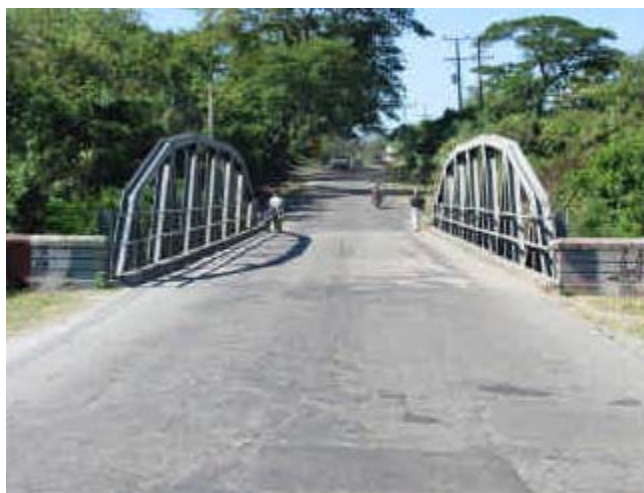
Figura 1.4 Puente de armazón lateral poligonal, "Ns" ubicado sobre el río Comalapa, departamento La Paz.
