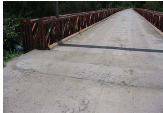
d) Calzada de concreto hidráulico.
