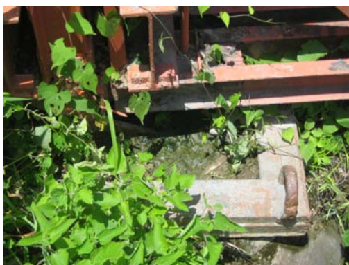
Figura 5.18 Puente Bailey, La Barra, TS - 200', Metapán.
