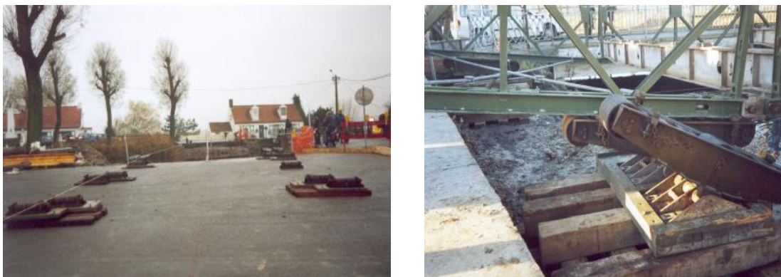
Figura 4.18 Colocación de rodillos planos y basculantes.
