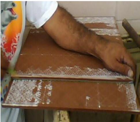
**Figura 3. 10** Medición y cortes de piezas de cerámica
