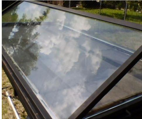
**Figura 3. 6** Vista de cubierta de vidrio luego que se seca el silicón
