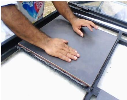
**Figura 3. 7** Instalación de cerámica para construcción de pileta (Evaporador)
