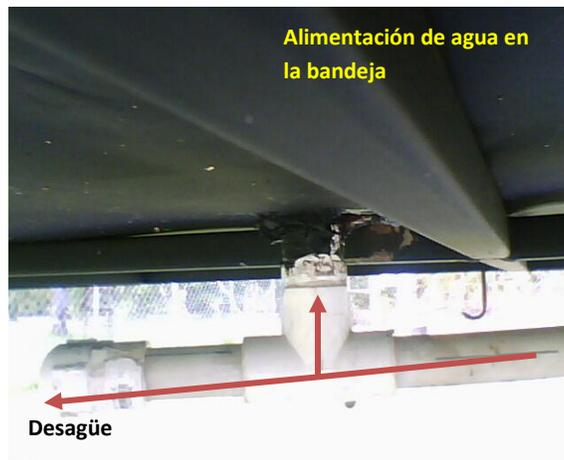
**Figura 3. 15** Tubería de alimentación de agua en bandeja de cerámica (efecto rebalse) y sistema de desagüe de bandeja
