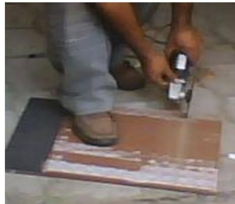
**Figura 3. 11** Ejecución de cortes precisos para construcción de bandeja
