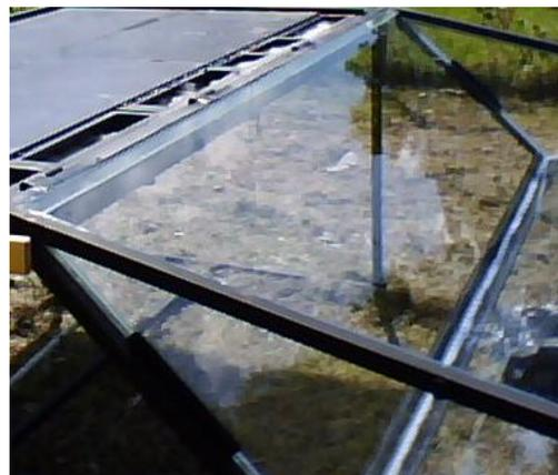
**Figura 3.5** Instalación de planchas de vidrio
