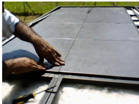
**Figura 3. 8** Vista de alineación de las piezas de cerámica al momento de instalarlas
