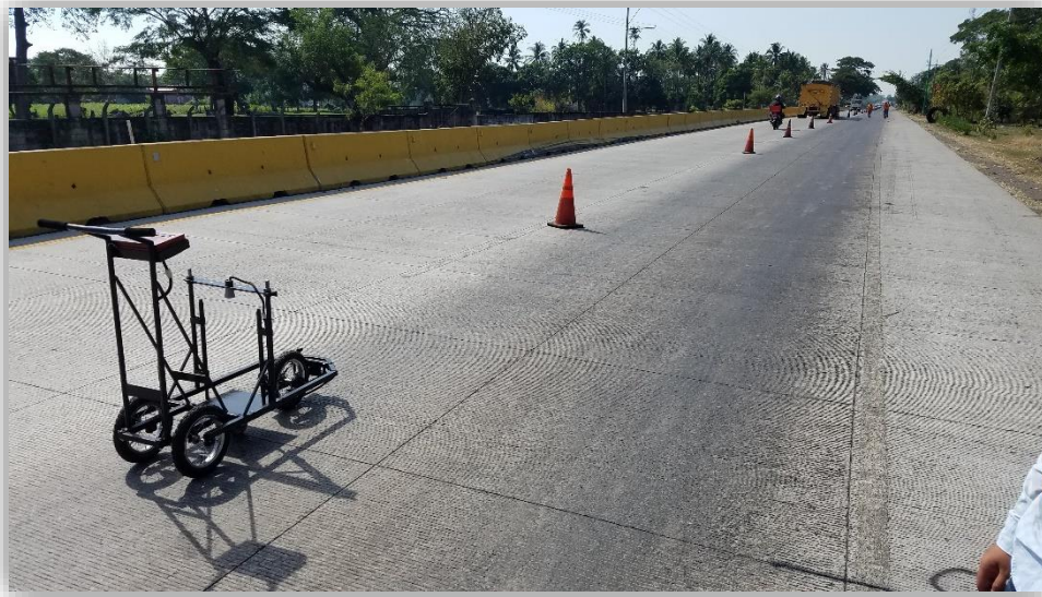
Figura 4 - 5 Tramo de 500 m de pavimento rígido. Fuente: Elaboración Propia
