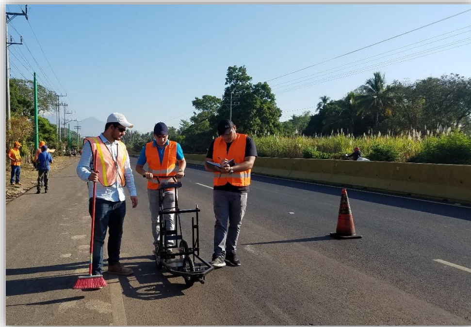
Figura 3 - 24 Recorrido del equipo sobre pavimento flexible. Fuente: Elaboración Propia
