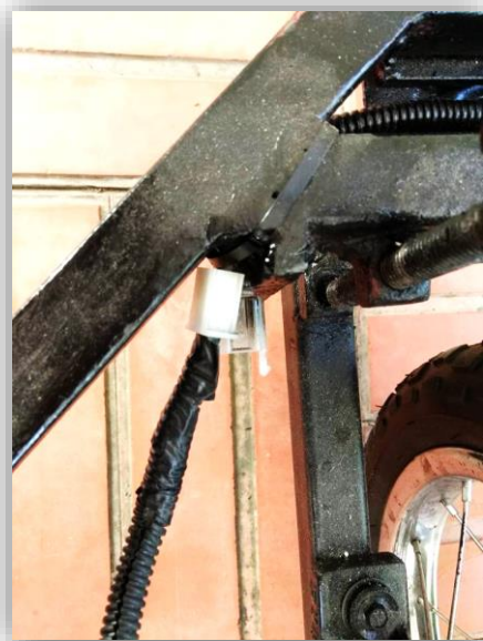
Figura 3 - 48 Conexión de Encoder. Fuente: Elaboración Propia
