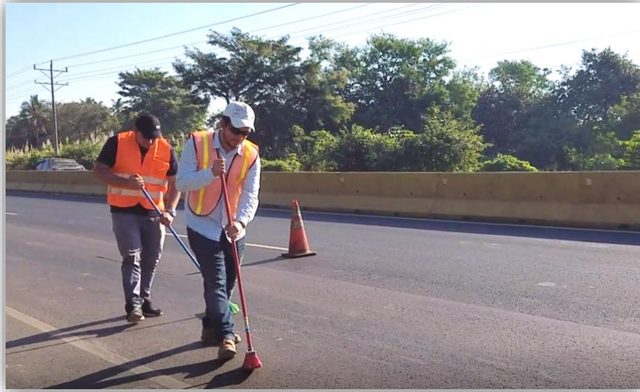
Figura 3 - 50 Se limpia la superficie del pavimento por donde pasará el perfilómetro. Fuente: Elaboración Propia
