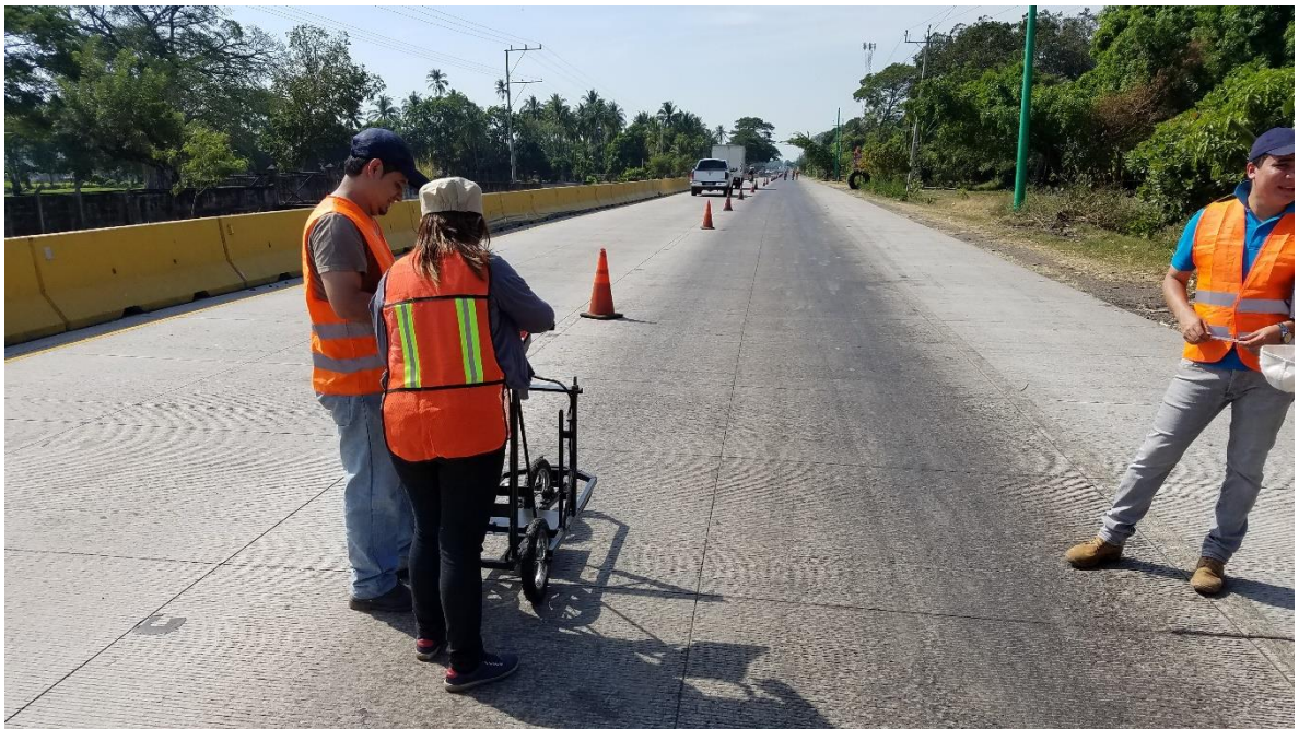
Posteriormente se procedió a hacer pruebas al tramo de pavimento rigido, el grupo de sistemas estuvo supervisando el funcionamiento del programa. Fuente: Elaboración Propia
