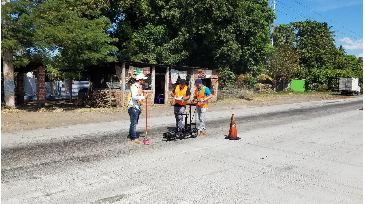
Se tomaron datos de 500 metros por cada huella en cada tramo, equivalente a 1 kilómetro por cada tipo de pavimento. Fuente: Elaboración Propia
