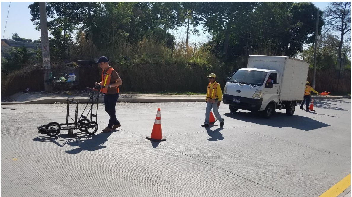
Tambien hubo una cuadrilla ayudando con la colocacion de conos para cerrar el carril en cuestion al trafico.
