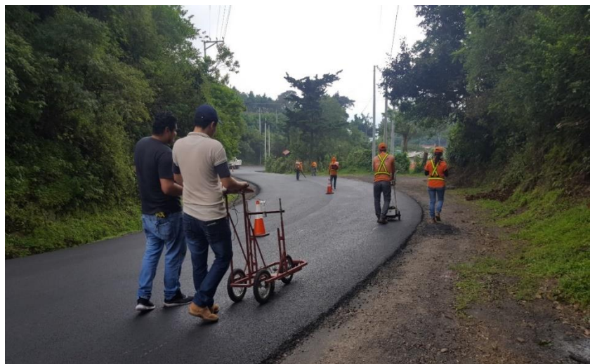
El equipo nuevo toma sus lecturas simultáneas al perfilómetro clase 1 sobre la misma huella. Fuente: Elaboración Propia
