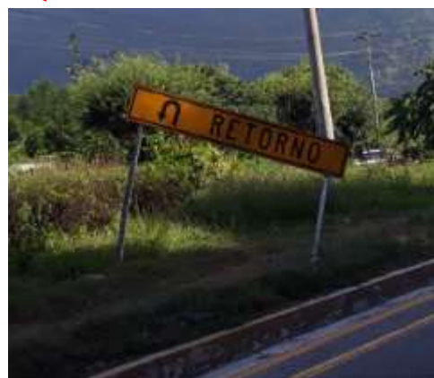
Figura 6.12 segmento 6: muestra señal vertical de retorno en malas condiciones
