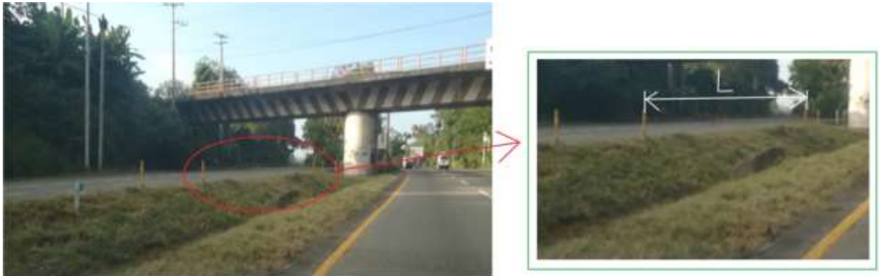
Figura 6.22 separación entre postes de contención
