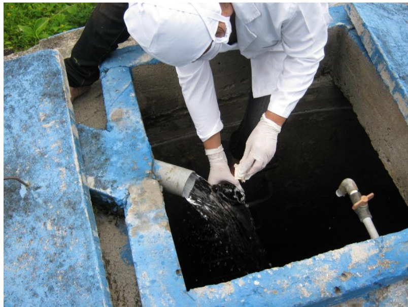
Fig. N° 9. Tanque de Barrio Concepción
