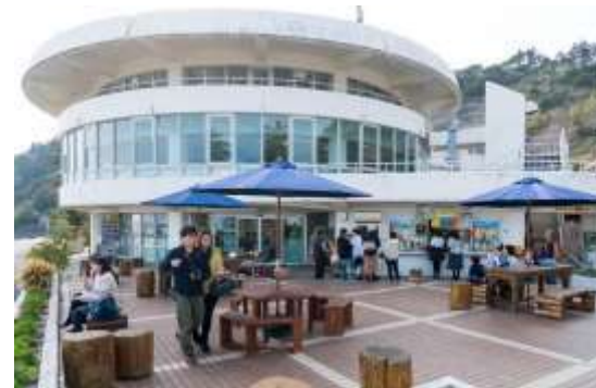
Ilustración 23,24,25,26,27: Vista varias estaciones de carretera
