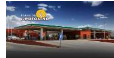
Ilustración 33: Vista Exterior de parador
