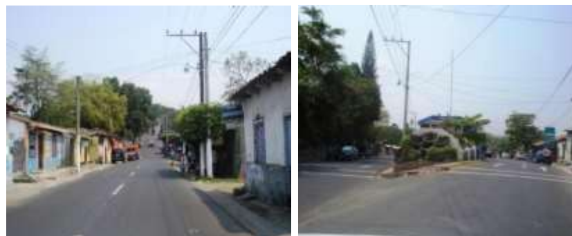
Fuente: Tomadas por el equipo en visita.
