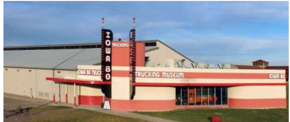
Ilustración 57: Vista exterior de parador
