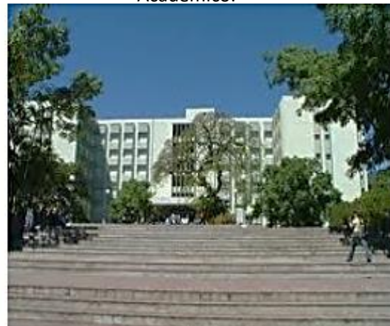
Fotografía 5. Edificio de Medicina. Uso: Académico.
