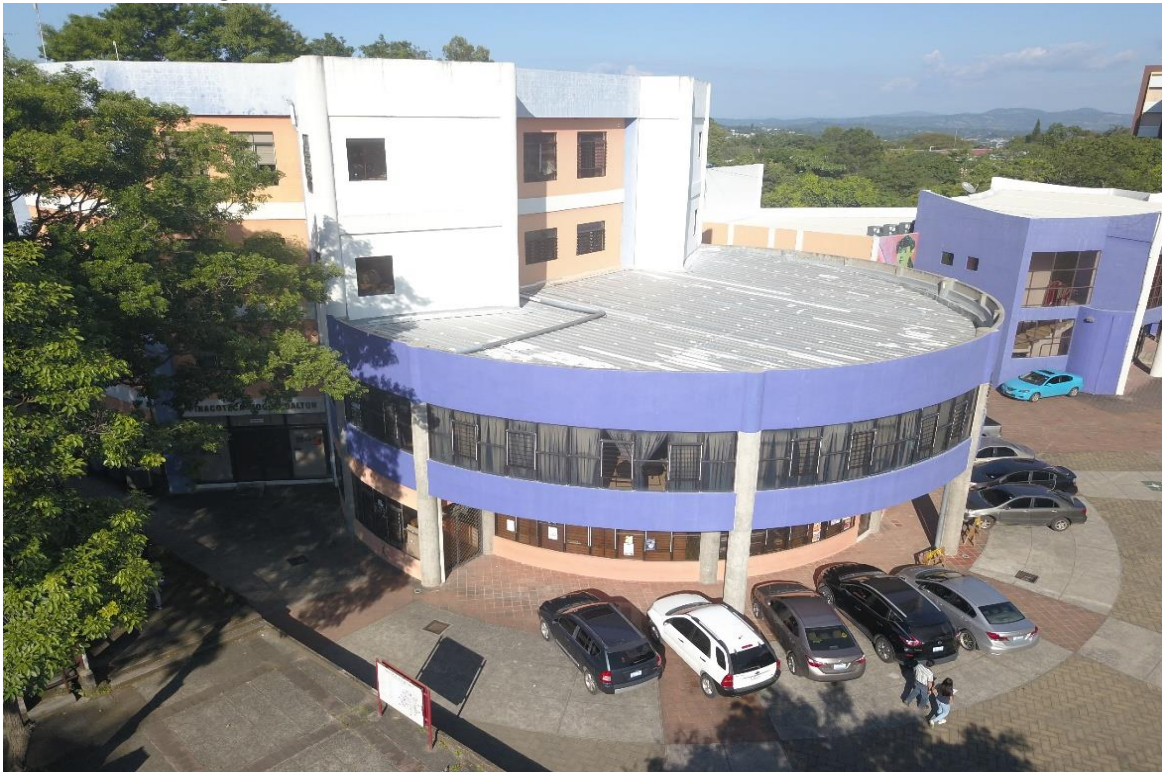
Fotografía 8. VISTA AÉREA DEL EXTERIOR DEL EDIFICIO EXISTENTE DE RECTORÍA.
