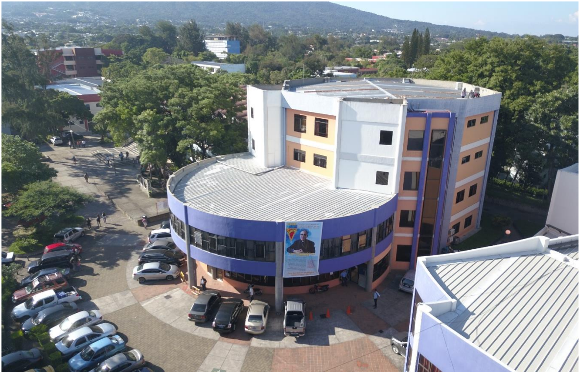
Fotografía 7. VISTA AÉREA DEL EDIFICIO EXISTENTE DE RECTORÍA.
