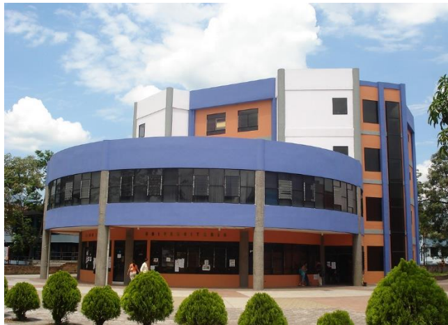
Fotografía 6. Fachada Principal Edificio de Rectoría.
