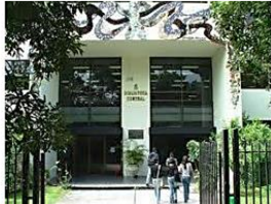
Fotografía 3. Edificio biblioteca central. Uso: Académico.
