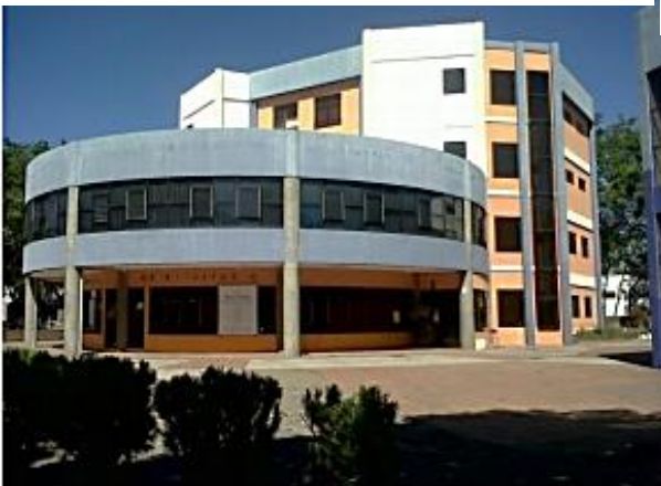
Fotografía 2. Edificio de Rectoría, Uso: Mixto.
