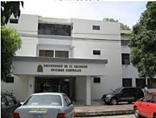
Fotografía 4. Edificio de Oficinas Centrales. Uso: Administrativo.
