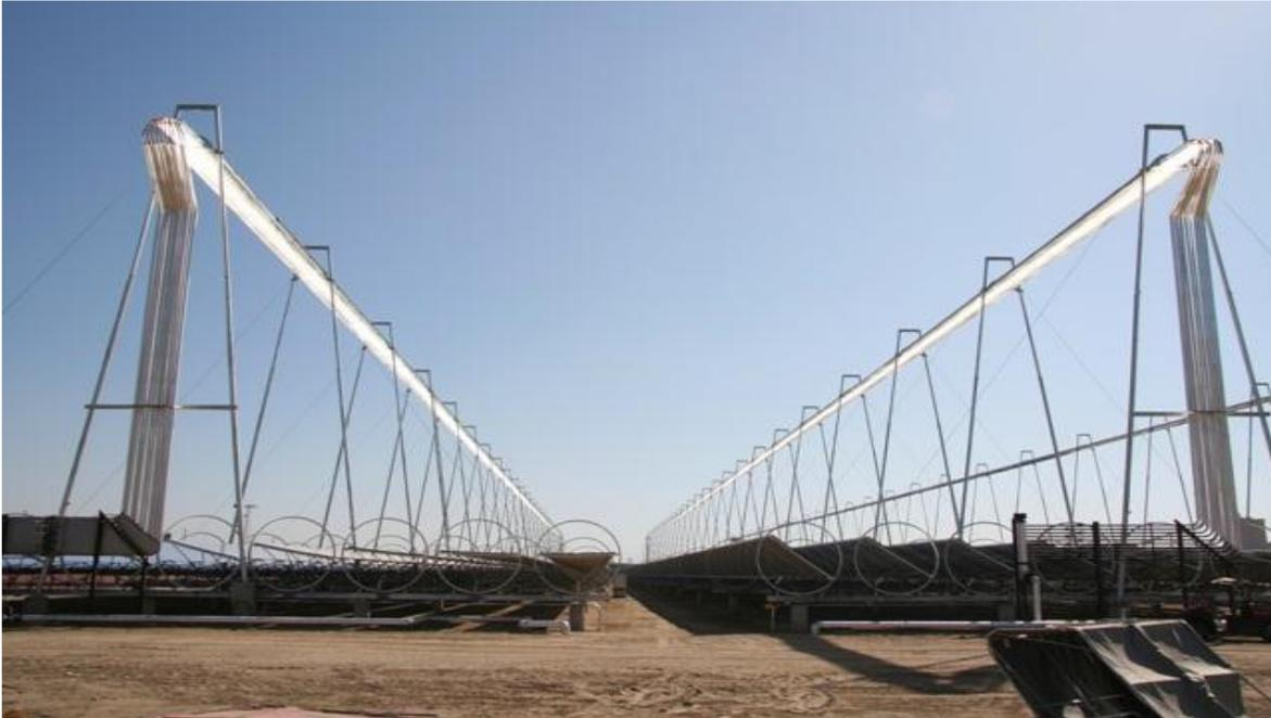
*Ilustración 9: Reflectores lineales Compactos Fresnel (Fuente: [www.nrel.gov](http://www.nrel.gov)).*
