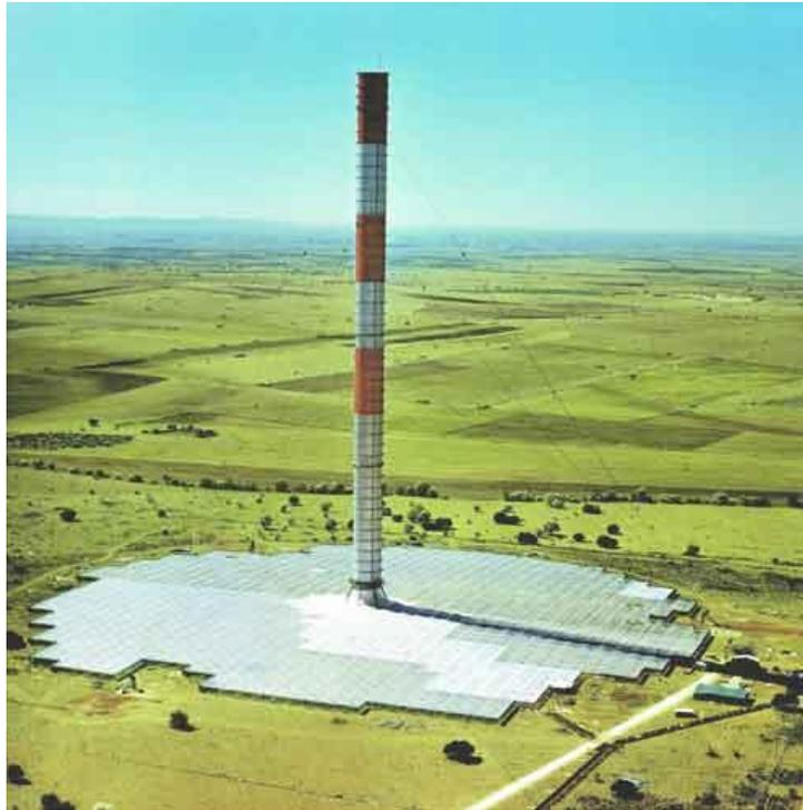
*Ilustración 14: Chimenea Solar, Manzanares (España) (Fuente: [www.stirlingengines.org.uk](http://www.stirlingengines.org.uk)).*
