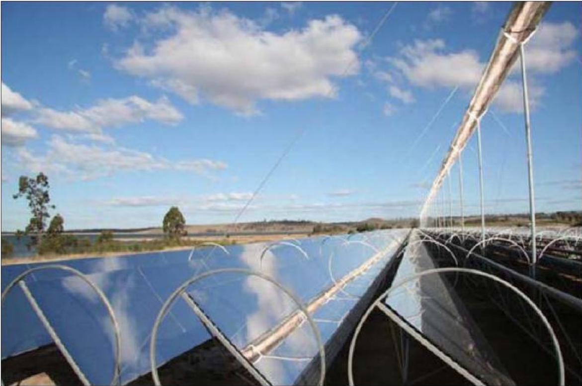
*Ilustración 8: Colector lineal Fresnel (Fuente: Universidad de Chile).*
