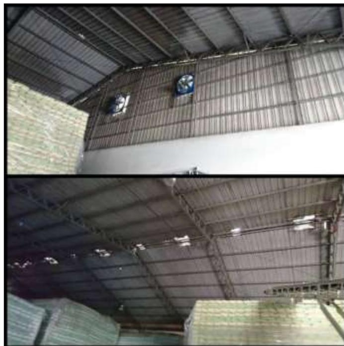
*Figura 2.5 Bodega 4 - Ventiladores ubicados en las paredes e inyectores de aire ubicados en la parte mas alta de la bodega.*
