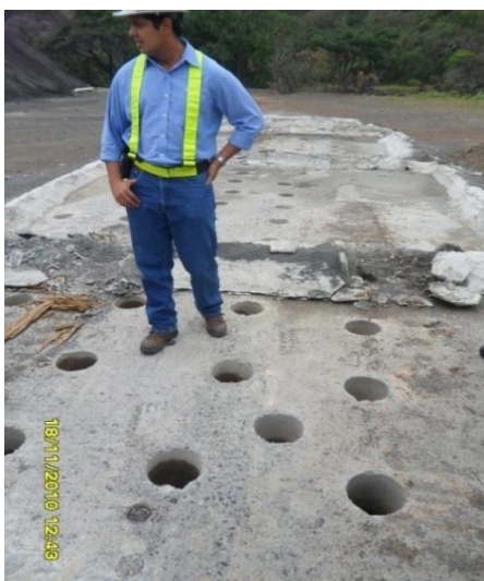
FIGURA N° 2.4: TRAMO DE PRUEBA CONCRETO COMPACTADO CON RODILLO CCR
