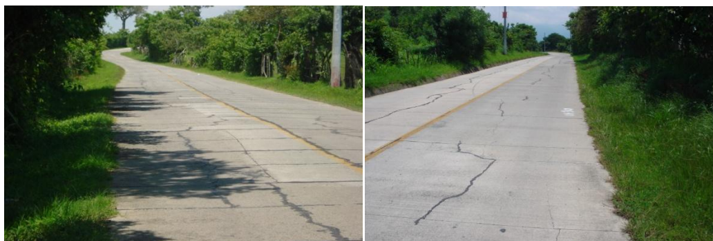
FIGURA N° 2.5: CALLE SANTA RITA, CHALATENANGO
