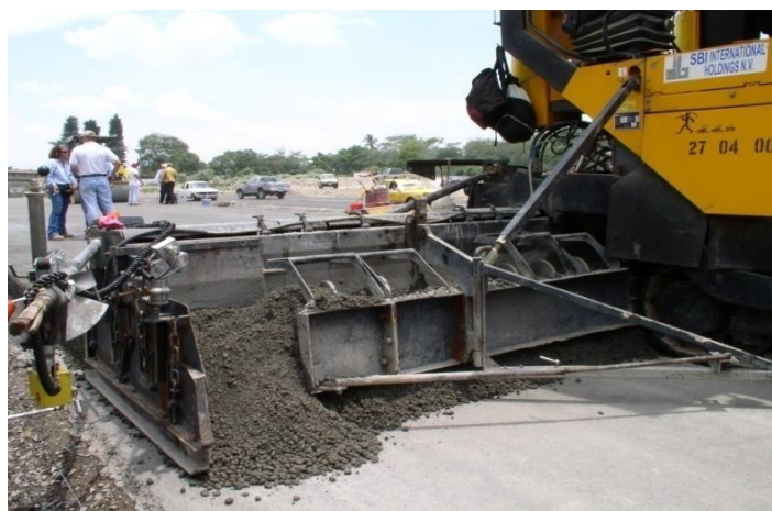
FIGURA N° 2.2: PAVIMENTADORA TITÁN 325 EPM UTILIZADA EN EL PROYECTO
