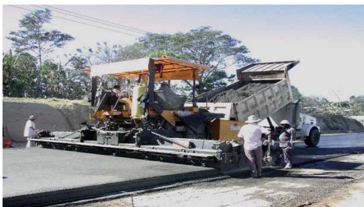
FIGURA N° 2.6: TRANSPORTE Y COLOCACIÓN DE CCR. MÁQUINA PARA MEZCLA ASFÁLTICA
