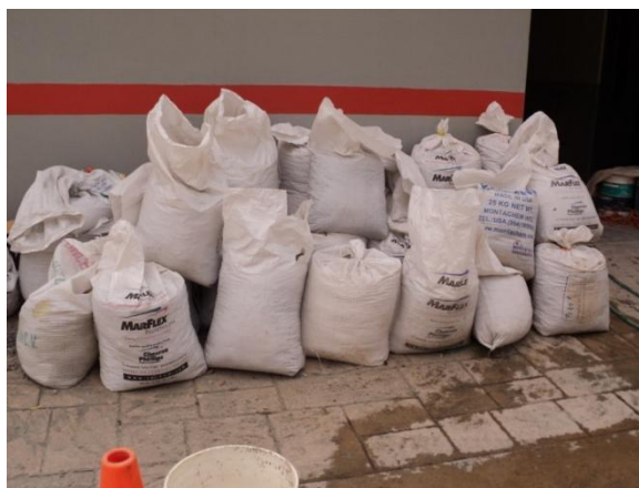
FIGURA N° 3.3: ACOPIO DE MATERIALES
