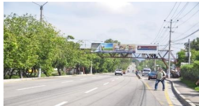
Imagen N°20. Pasarela sobre Autopista a Comalapa Fuente: Página web, Mapio.net
