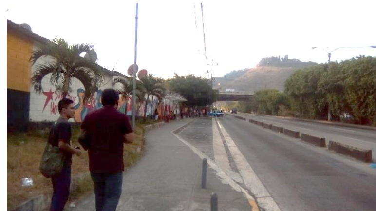
Imagen N°25. Vista de la fachada Oeste de la terminal del sur
