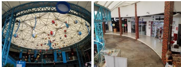
Imagen N° 123 y 124: Cubierta de Membrana, Piso Pulido y Columnas.
