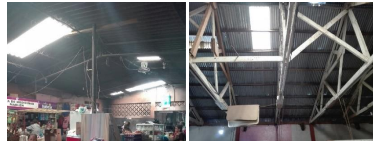
Imagen N° 31: Laminas Traslucidas en Techos.
