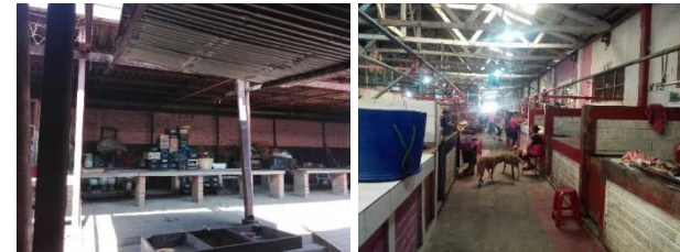
Imagen N°85 y 86: Paredes De Ladrillo De Barro.
