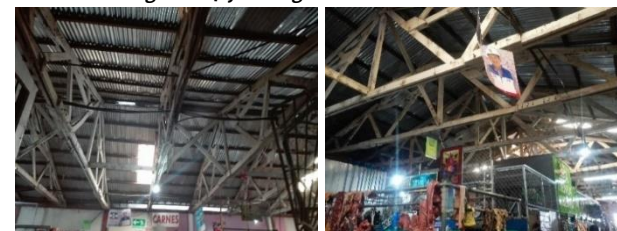
Imagen N°87 y 88: Vigas De Armadura Alemana.
