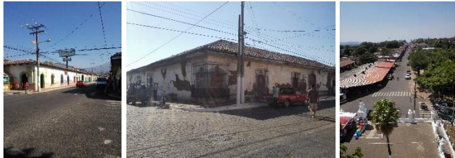
Imagen N° 32, 33 y 34: Calles del Casco Urbano de Izalco.
