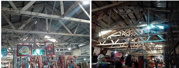
Imagen N°79 y 80: Estructuras de Techo Compuesta por Vigas de Madera.
