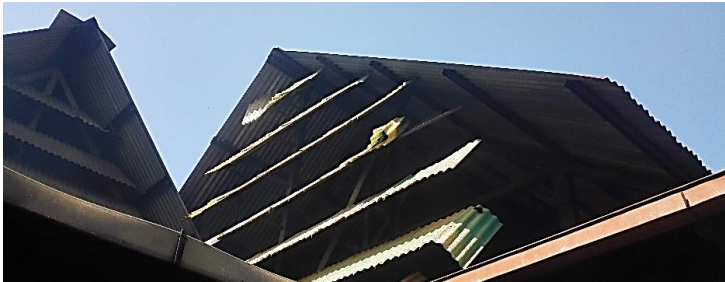
Imagen N° 25: Laminas a 45° En Extremos De Techos Para Ventilación.
