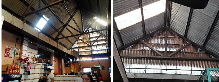
Imagen N° 25: Laminas a 45° En Extremos De Techos Para Ventilación.
