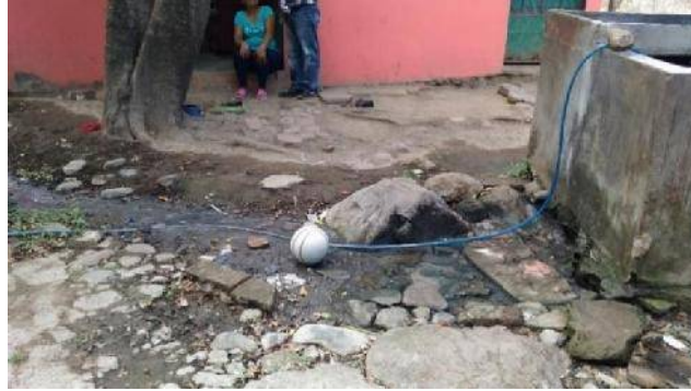
Fotografía 24. Desalojo de aguas residuales en comunidad Callejón Huacachala
