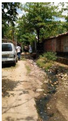
Fotografía Nº22. Desalojo de aguas residuales de comunidad Callejón Huacachala.
