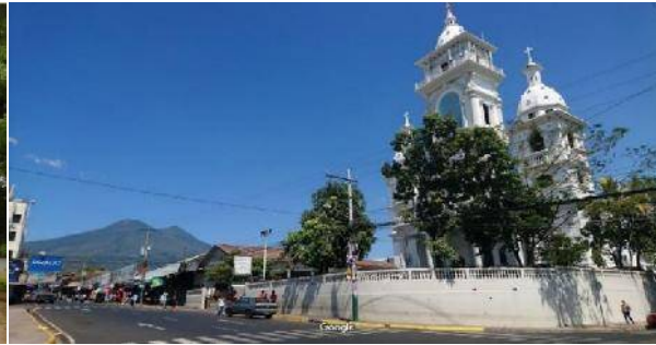
Fotografía N°5. Av. Juan Manuel Rodríguez
