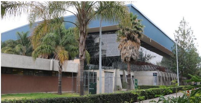
IMAGEN Nº 135: VISTA EXTERIOR COMPLEJO ACUÁTICO.
