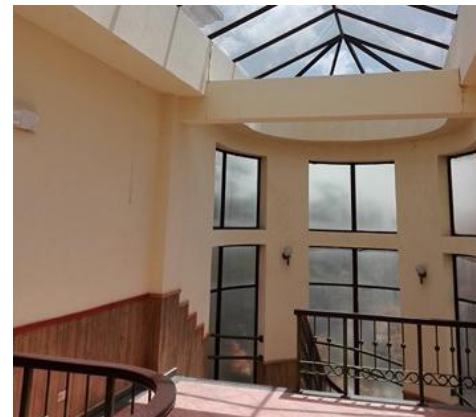
IMAGEN N° 122: ESCALERAS Y TECHO TRASLUCIDO.
