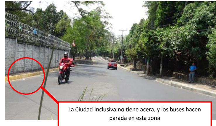
IMAGEN Nº 47: MAL ESTADO DEL EQUIPAMIENTO URBANO.
