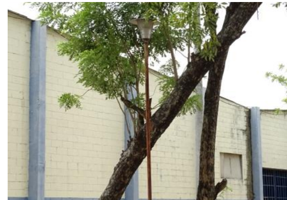
IMAGEN Nº 64: POSTES CON LUMINARIAS PARA EL TRANSITO PEATONAL DENTRO DE LA VILLA
