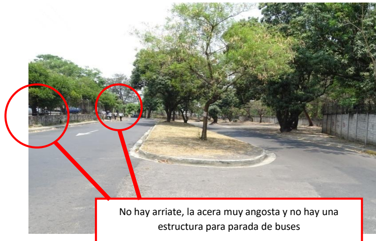
IMAGEN Nº 46: MAL ESTADO DEL EQUIPAMIENTO URBANO.
