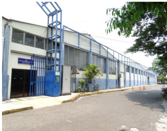
IMAGEN N° 110: FACHADA ESTE (FACHADA PRINCIPAL).
