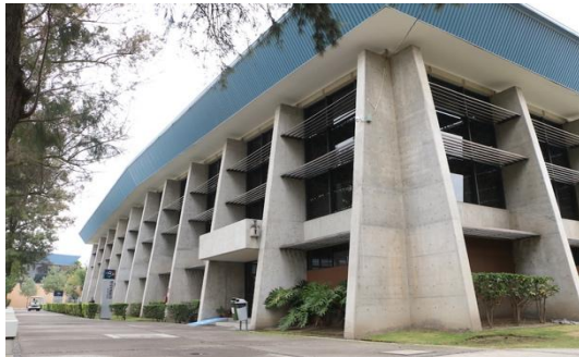
IMAGEN Nº 131: VISTA EXTERIOR PABELLÓN DE GIMNASIA.
