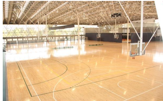
IMAGEN Nº 133: VISTA INTERIOR PABELLÓN DE PELOTA.
