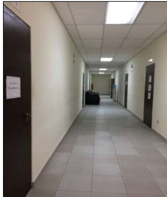
Figura 3.6-7 Reducción de fugas de aire con puertas cerradas, cuando los sistemas de aire acondicionado están encendidos. Fuente: Propia
