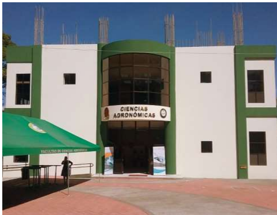
Figura 2.2-3 Edificio del Instituto de Investigaciones Agroalimentarias, Ambientales y Escuela de Postgrado y Educación Continua. Fuente: Propia.
