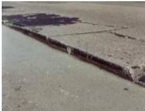
Figura 2.21 Despostillamiento
