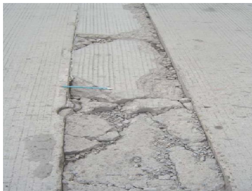
Figura 2.30 Parchados y Reparaciones de Servicios Públicos
