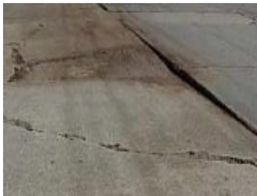
Figura 2.22 Hundimiento
