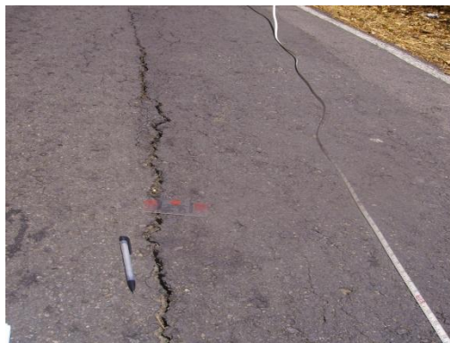
Figura 2.35 Fisura Longitudinal
