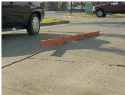
Figura 2.20 Levantamiento de Losas
