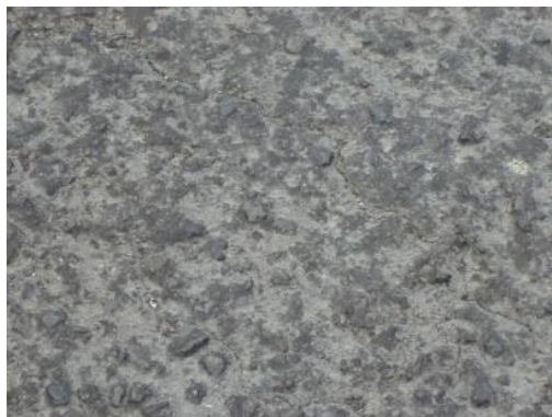
Figura 2.43 Peladura
