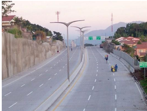
Figura 2.6 Carretera de Concreto Hidráulico
