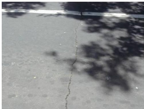
Figura 2.34 Fisura Transversal
