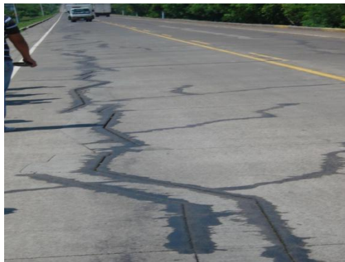
Figura 2.19 Fisuras Inducidas
