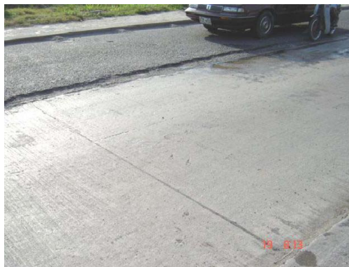
Figura 2.24 Pulimiento de la Superficie
