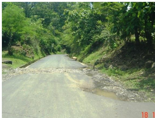
Figura 2.44 Desintegración de Bordes
