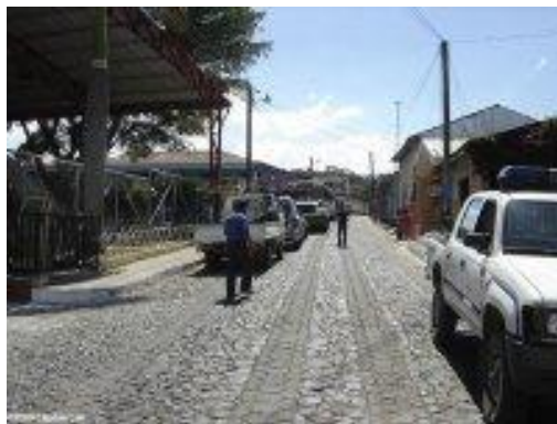
Figura 2.4 Calle de Adoquines
