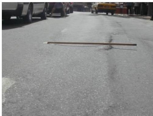
Figura 2.37 Ahuellamiento
