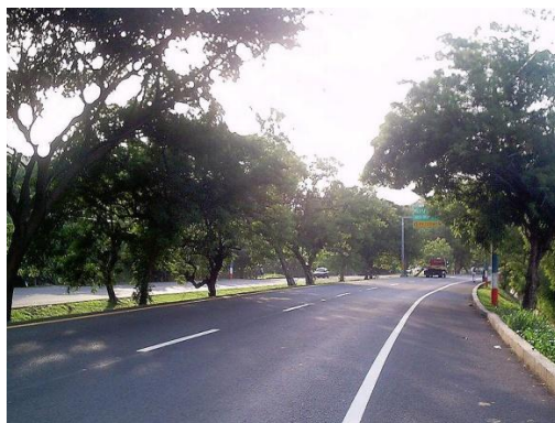
Figura 2.5 Carretera de Concreto Asfáltico
