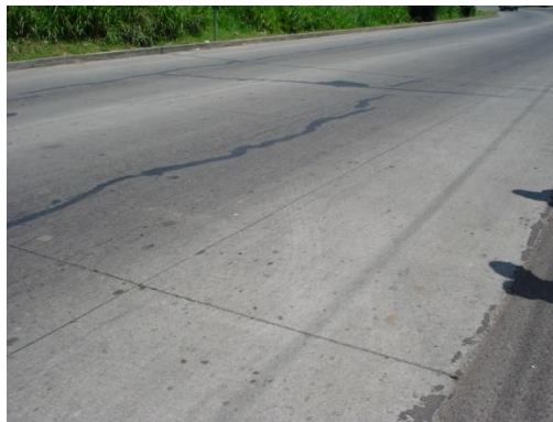
Figura 2.14 Fisura Longitudinal
