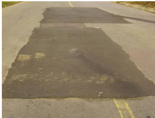
Figura 2.46 Parchados y Reparaciones de Servicios Públicos
