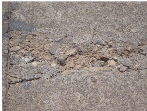
Figura 2.23 Peladura
