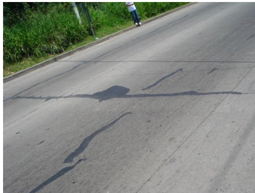
Figura 2.17 Losas Subdivididas
