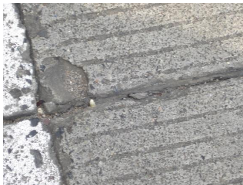
Figura 2.28 Despostillamiento
