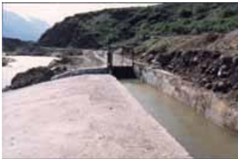
b) Canal revestido de mampostería de piedra.
