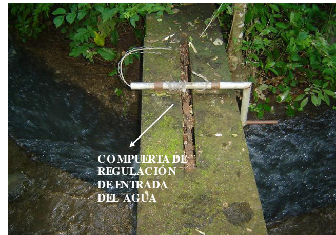
Dique de mampostería de piedra con recubrimiento de concreto y vertedero de 0.60 m de ancho.
