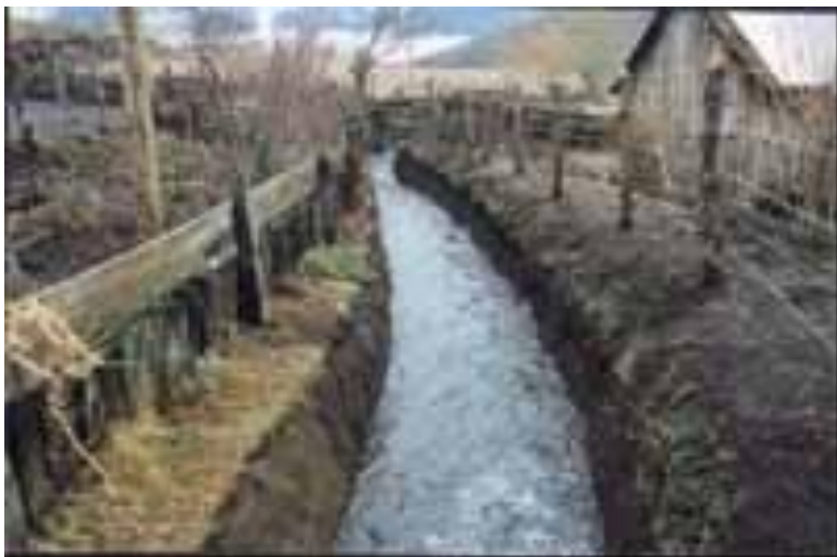
a) Canal de tierra.
