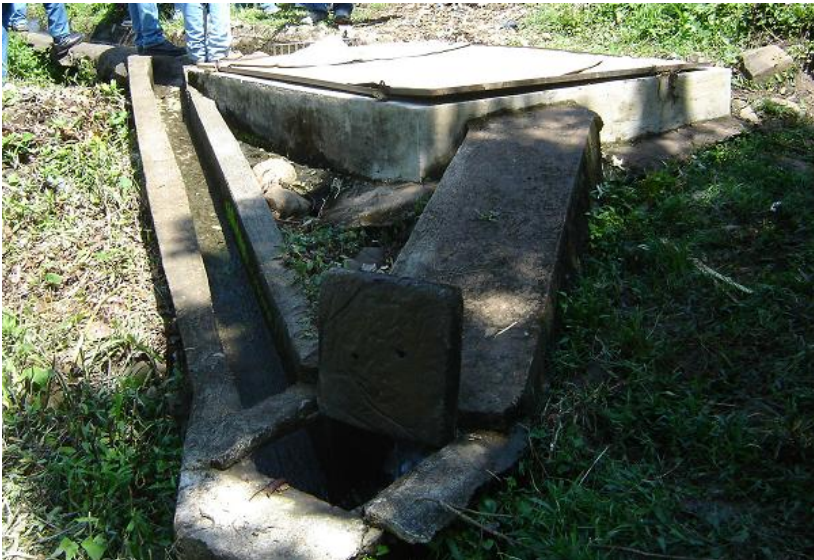
Cámara de Carga
