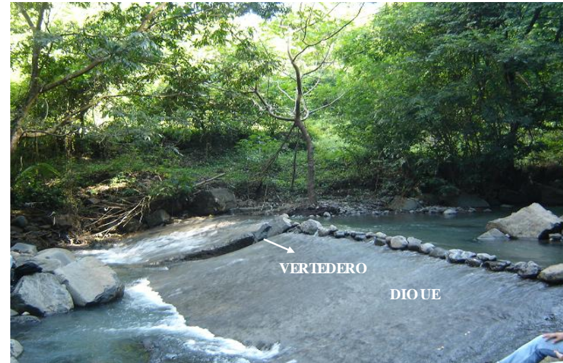
Dique de mampostería de piedra con recubrimiento de concreto y vertedero de 0.60 m de ancho.
