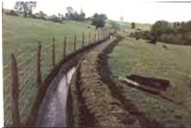
b) Canal revestido de mampostería de piedra.
