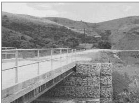
Figura 2.17 Estribo de Mampostería de piedra.
