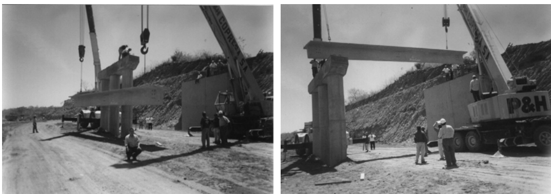
Figuras A.8 y A.9 Montaje de vigas prefabricadas
