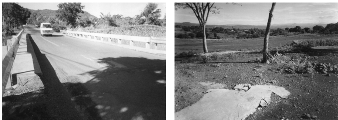
Figura A.23 y A.24 Condiciones finales del proyecto.
