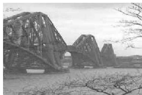
Figura 1.7 Puente de armadura en Cantiver.
