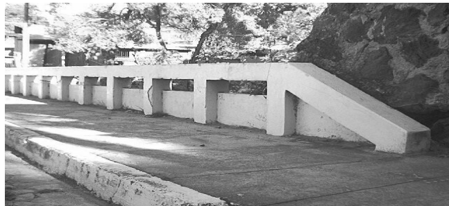
Figura 2.30 Acera de concreto, Puente “El Garrobo, Col. Costa Rica, San Salvador
