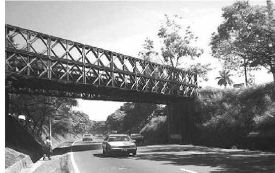
Figura 1.9 Puente con armadura metálica superior tipo bailey.
