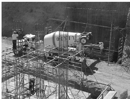
Figura A.4 Armado de pila
