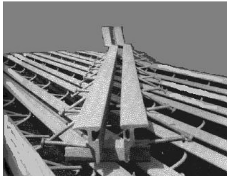
Figura No. 26. Angulares para el Sello de Franja.
