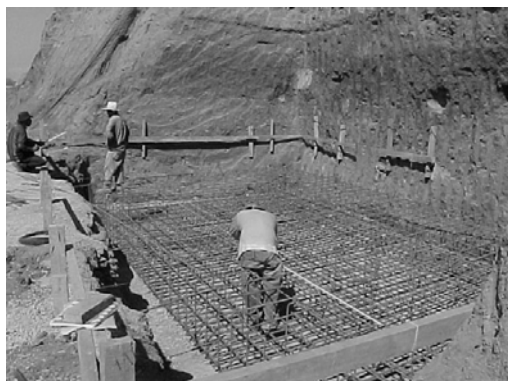
Figuras A.3 Armado de zapata de estribo
