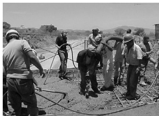
Figura A.16 Proceso de colado de losa
