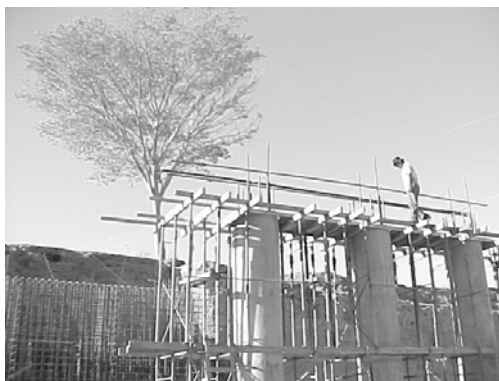
Figura A.6 Moldeado de pilas
