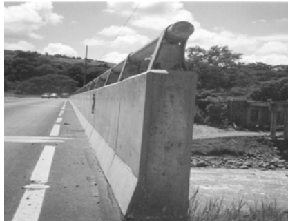
Figura 2.29 Barandal de concreto presforzado.
