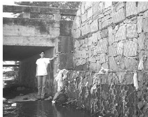
Figura 2.26 Muros Gaviones en Puente El Garrobo, Col. Costa Rica, San Salvador, El Salvador
