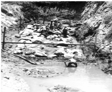
Figura 2.21 Puente Yotaiquim, México.
