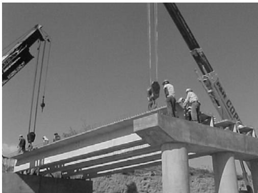
Figuras A.10 Montaje de vigas prefabricadas
