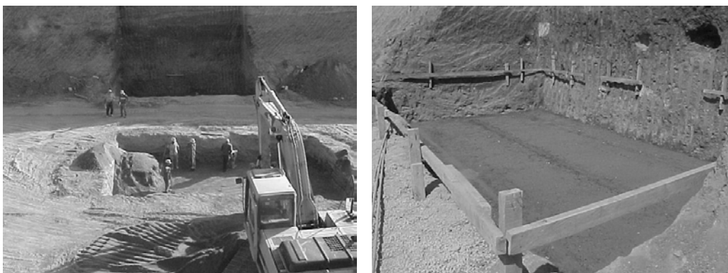
Figura A.2.1 , A.2.2 Proceso de excavación
