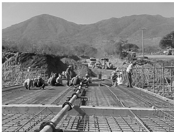
Figura A.12 Colado de diafragmas
