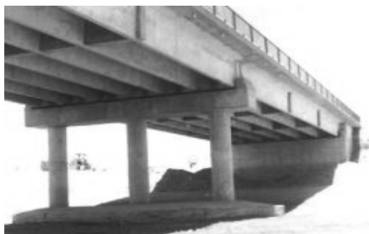
Figura 2.19 Pila Columnas Múltiples construida sobre tierra Figura 2.20 Pila tipo pared construida en zona marítima.
