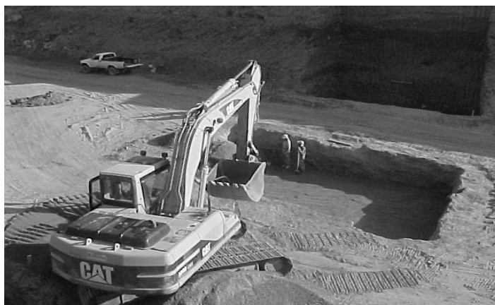
Figura 4.2.a Excavación de pila central, Puente Conchagua, La Unión.
