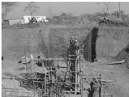
Figuras A.5 Moldeado de pilas
