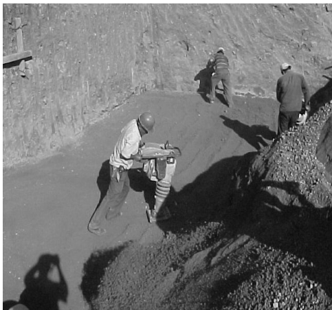
Figura 4.2.b Cimentación de pila, Puente Amapolita, La Unión.
