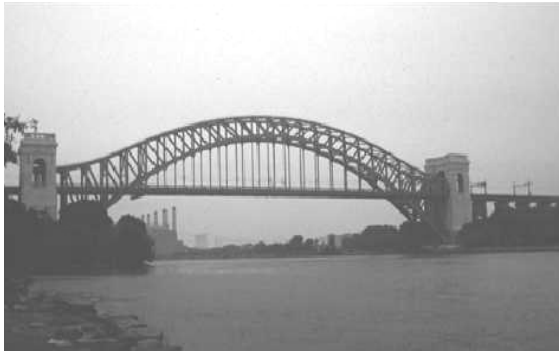
Figura 1.8 Puente con armadura metálica y arriostramiento superior .
