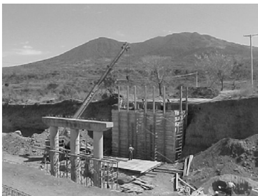
Figura A.7 Moldeado de estribo
