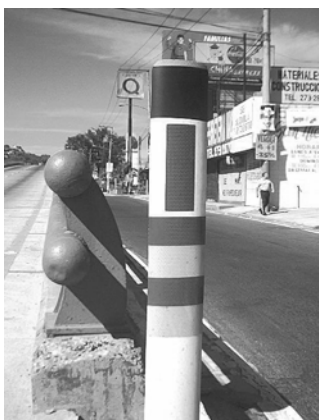
Figura 2.27 Barandal Metálico vista transversal.
