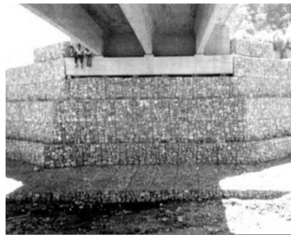
Figura 2.18 Estribo de Mampostería de piedra.
