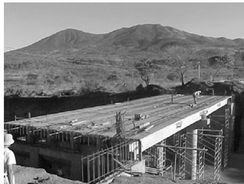
Figura A.11 Colocación final de vigas
