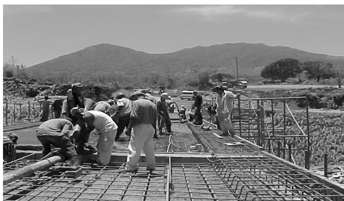
Figura 4.6 Colado de losa y aceras, puente Conchagua, La Unión, El Salvador.
