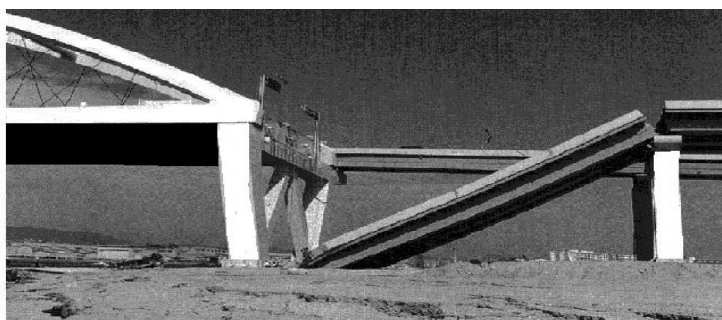
Figura No. 3 Puente Nishinomiya-ko
