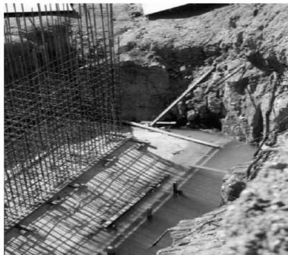
Figura 2.22 Puente Caramicuas, México
