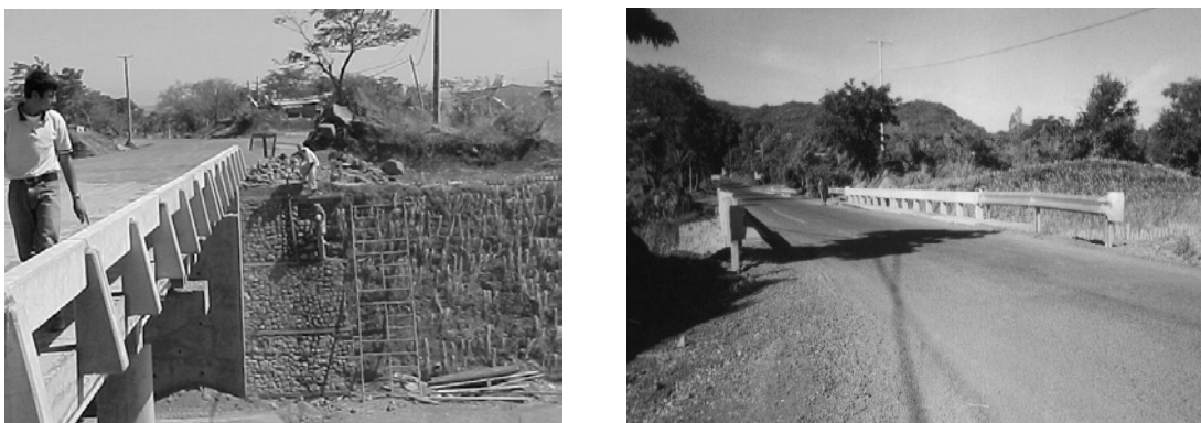
Figura A.19 y A.20 Obras de protección
