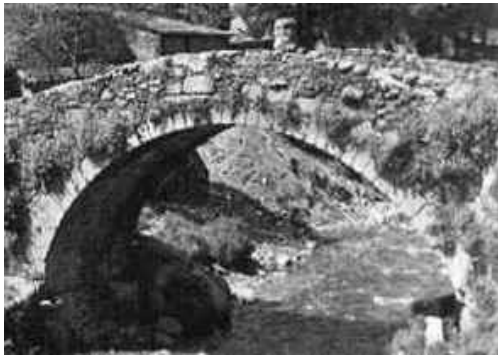
Figura 1.4 Puente de arco en mampostería.
