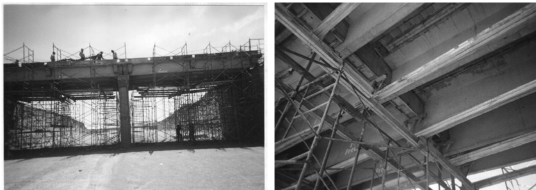
Figura A.13 y A.14 Armado de losas principales
