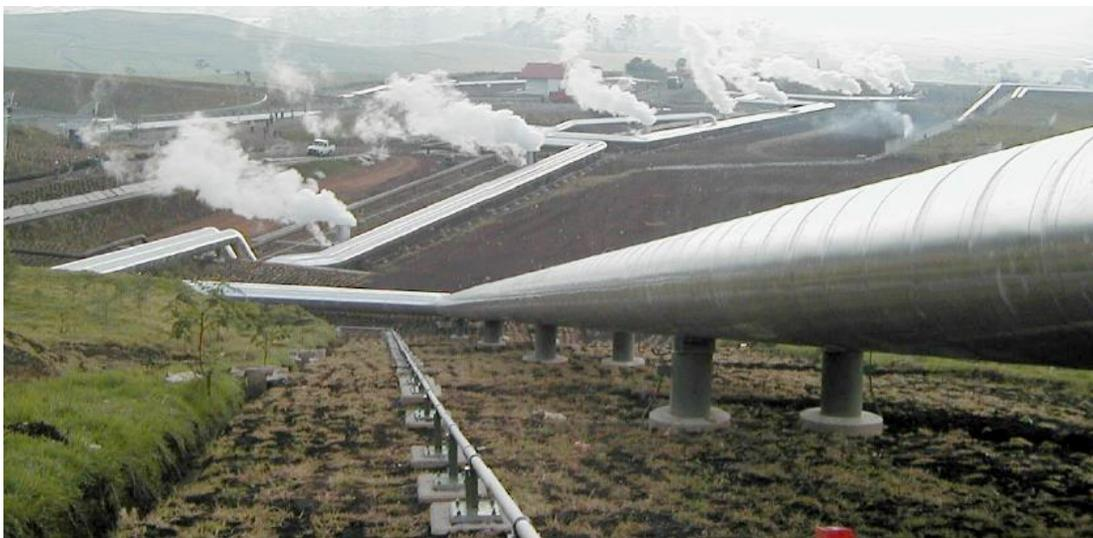
Figura 1.3. Tuberías de acarreo en Central Geotérmica
