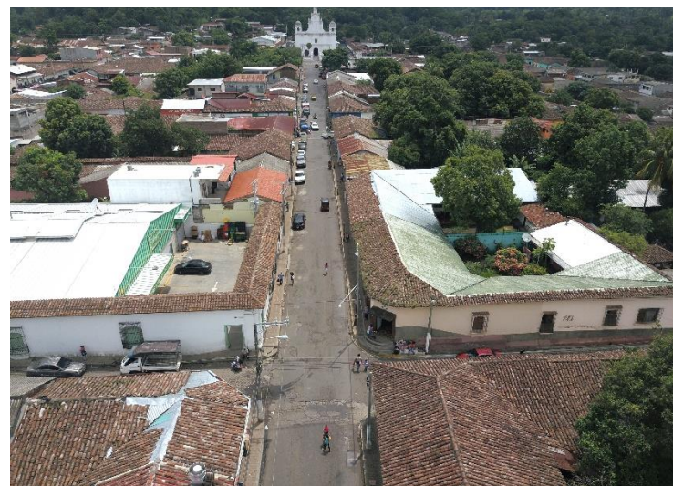
Ilustración 46 Vista 4 Sobre Av Morazán
