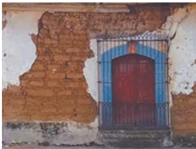
Ilustración 64 Adobe visto en casa Barriento
