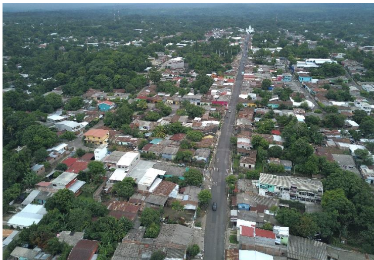
Ilustración 44 Vista 1 Sobre Av Morazán
