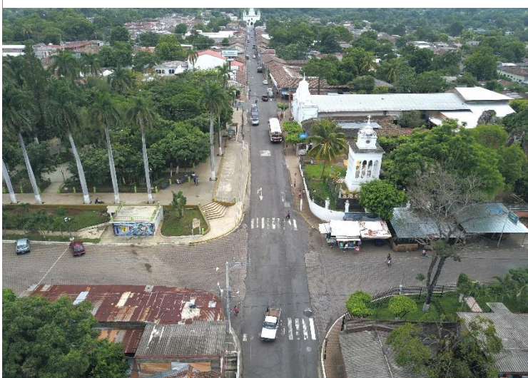
Ilustración 47 Vista 2 Sobre Av Morazán
