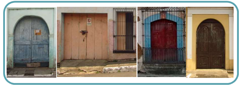
Ilustración 80 Puertas y ventanas de madera.
