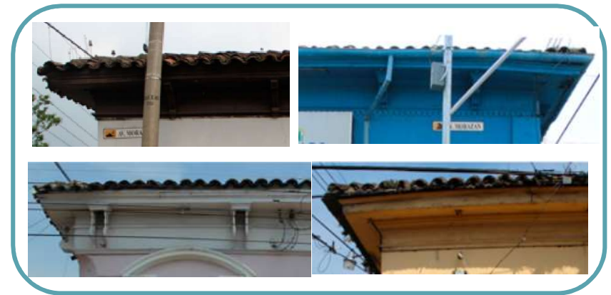
Ilustración 76 Ejemplos de cornisa encontrados en Izalco.
