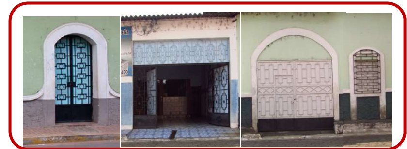
Ilustración 81 Puertas y ventanas de metal
