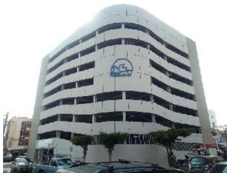
Fotografía 86: Intervención de Cableado subterráneo, mejorando la imagen urbana de la zona
