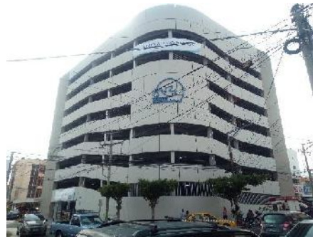
Fotografía 85: Actualmente con fachadas saturadas por instalaciones eléctricas.
