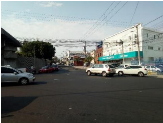
Fotografía 84: Falta de señalización horizontal y vertical.
