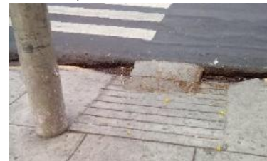
Fotografía 78, 79: Rampas de accesibilidad urbana que no cumplen con normativa en 25 Av. Norte Hospital Rosales (Izquierda) y Colonia Médica (Derecha)
