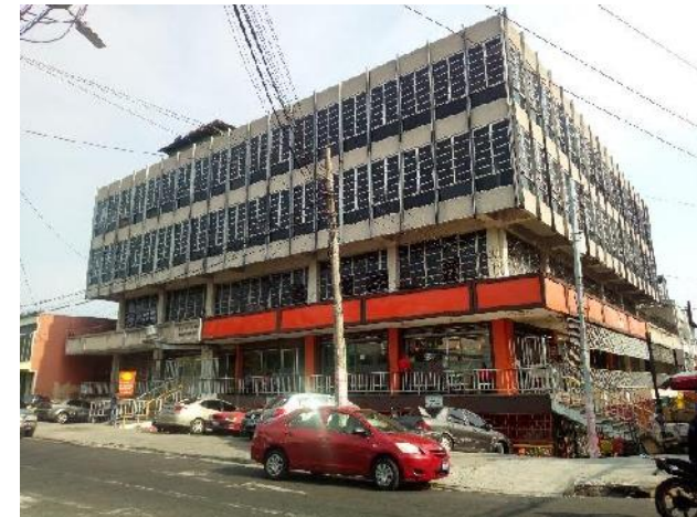
Fotografía 87: Estado actual de edificio comercial
