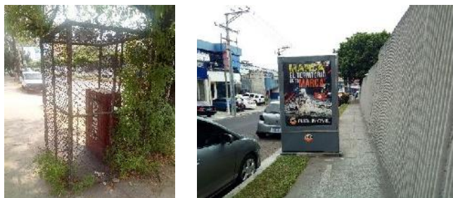
Fotografía 62, 63: Cajas telefónicas y mupis mal ubicados.
