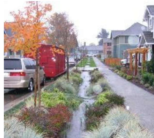
Imagen 53: Ejemplo de biofiltración en áreas verdes públicas , National Association of city transportation officials (NACTO).
