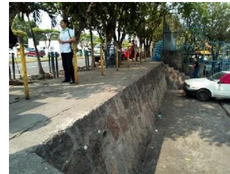
Fotografía 80: Diferencia de nivel que necesita un pasamano zona Hospital Bloom.
