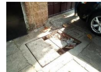
Fotografía 56: Cajas de contadores de agua potable sin tapadera, Tapaderas de cajas telefónicas colocadas sobre el nivel de acera y en estado deplorable en Colonia Médica
