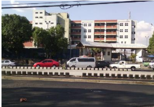
Fotografía 42: Hospital General del ISSS, ubicado sobre Alam. Juan Pablo II
