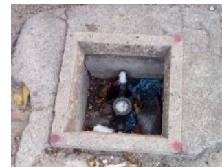
Fotografía 56: Cajas de contadores de agua potable sin tapadera, Tapaderas de cajas telefónicas colocadas sobre el nivel de acera y en estado deplorable en Colonia Médica
