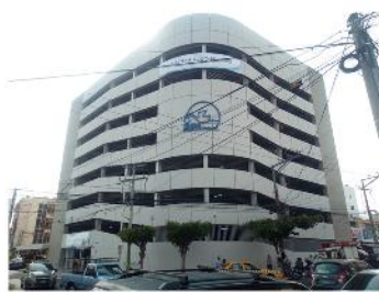
Fotografía 30: Edificio de estacionamiento de 7 niveles
