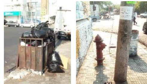
Fotografía 64: Diseño de basurero no apropiado e Hidrante mal ubicado.
