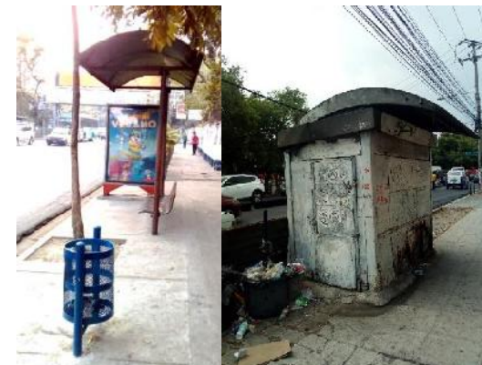
Fotografía 66: Parada de buses deficiente y kioscos en mal estado
