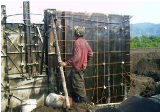
Figura 2.16. Colocación de molde metálico
