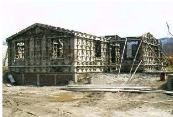
Figura 2.17. Vista general de encofrado metálico
