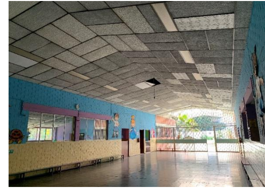
Fotografía N°21, Salón de usos múltiples
