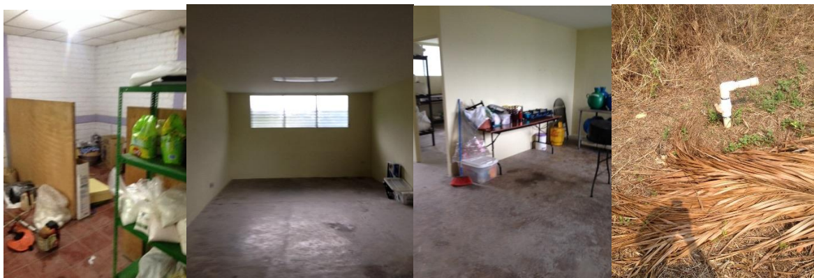
Ilustración 93: Instalaciones del CIETTA
