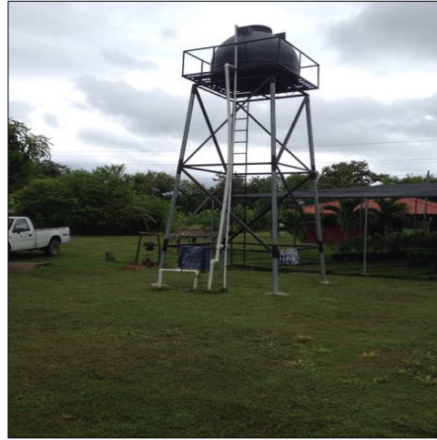
Ilustración 124: Cisterna de agua
