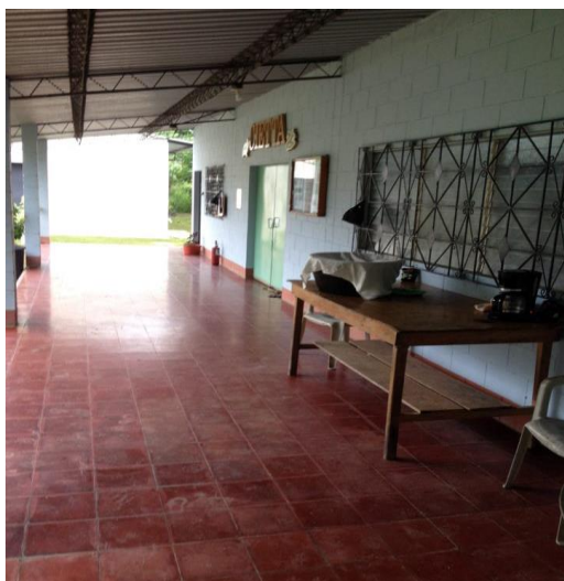
Ilustración 100: Instalaciones del CIETTA
