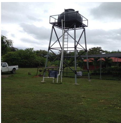
Ilustración 91: Cisterna de agua en el CIETTA
