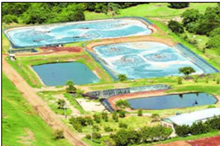
Figura 1.15 Instalaciones de relleno sanitario de Nejapa. Fuente: (Carranza, 2006)
