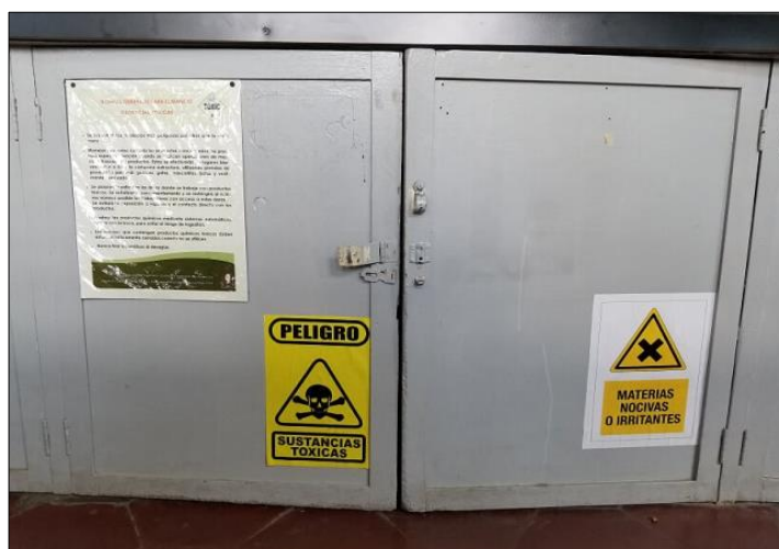
Figura 2.46 Área de almacenamiento para residuos y desechos tóxicos y nocivos (Exterior) del laboratorio académico de Ingeniería Química
