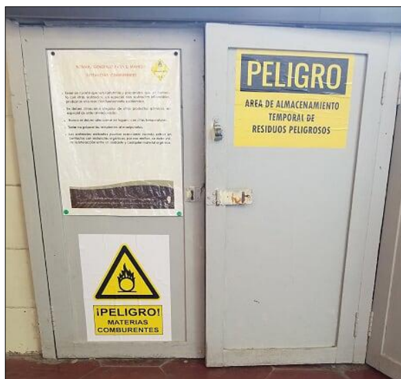
Figura 2.44 Área de almacenamiento para residuos y desechos comburentes (Exterior) del laboratorio académico de Ingeniería Química
