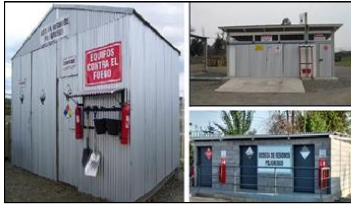
Figura 3.20 Diferentes bodegas de almacenamiento temporal de residuos peligrosos. Fuente: (Socoam, 2018)
