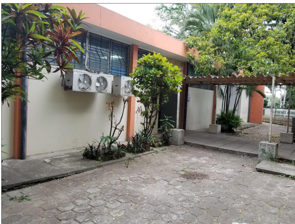
Figura 2.5 Entrada a los laboratorios académicos de Ingeniería Química de la Universidad de El Salvador
