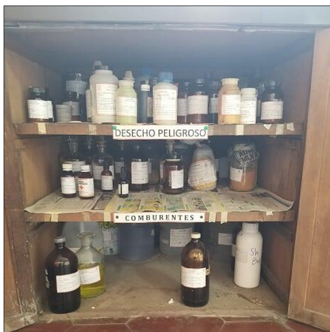
Figura 2.45 Área de almacenamiento para residuos y desechos comburentes (Interior) del laboratorio académico de Ingeniería Química
