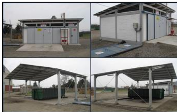
Figura 3.25 Piso ligeramente liso y libre de grietas bodega de residuos y desechos peligrosos. Fuente: (Socoam, 2018)
