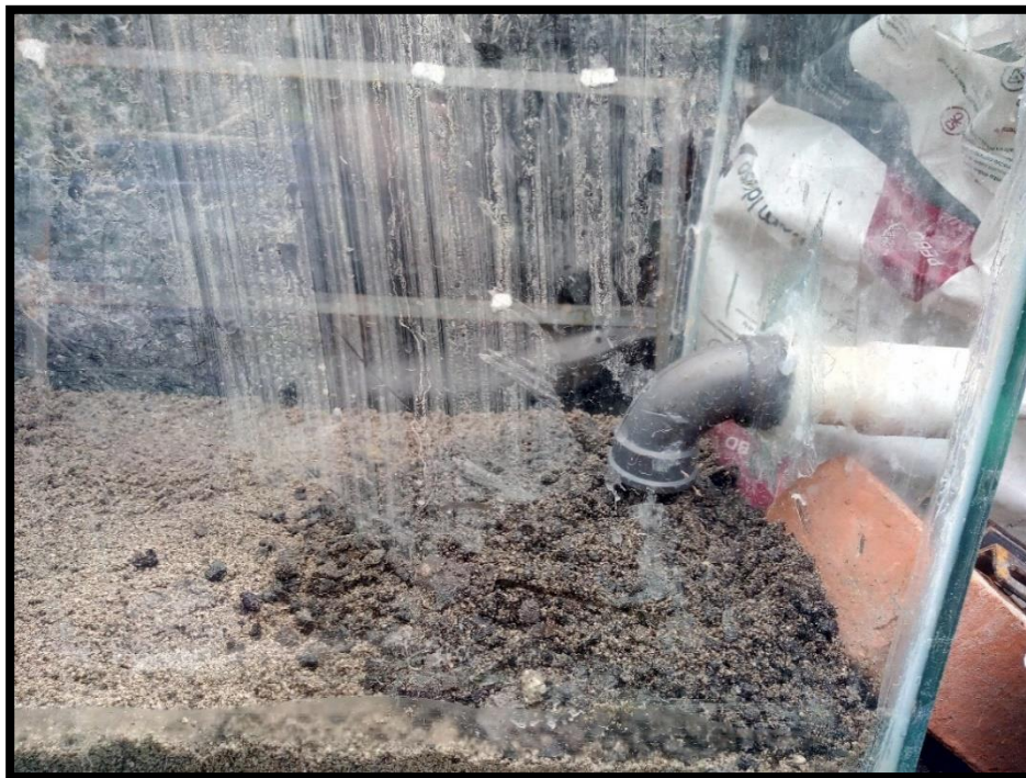
Figura 11.6 Colocación del material filtrante (arena y gravilla).
