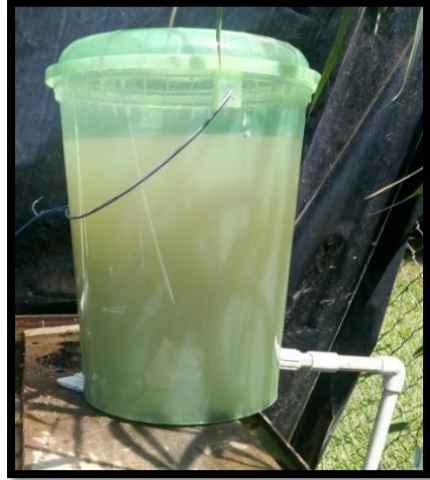
Figura 3.7 Depósito para almacenamiento de las aguas residuales.
