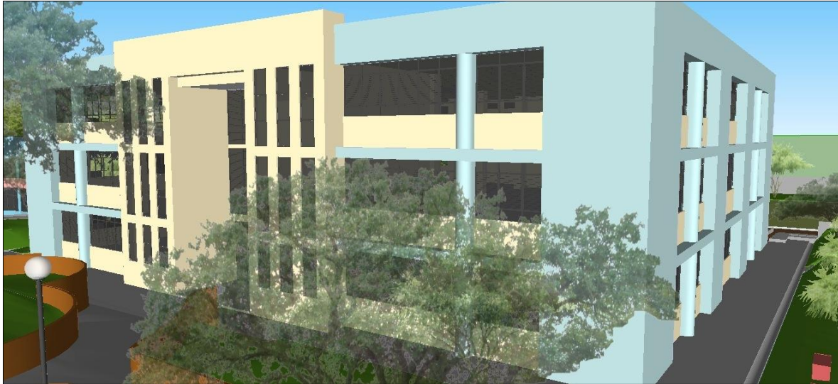
Figura 3. 3. Vista 1 del costado oriente del edificio "Usos Múltiples".
