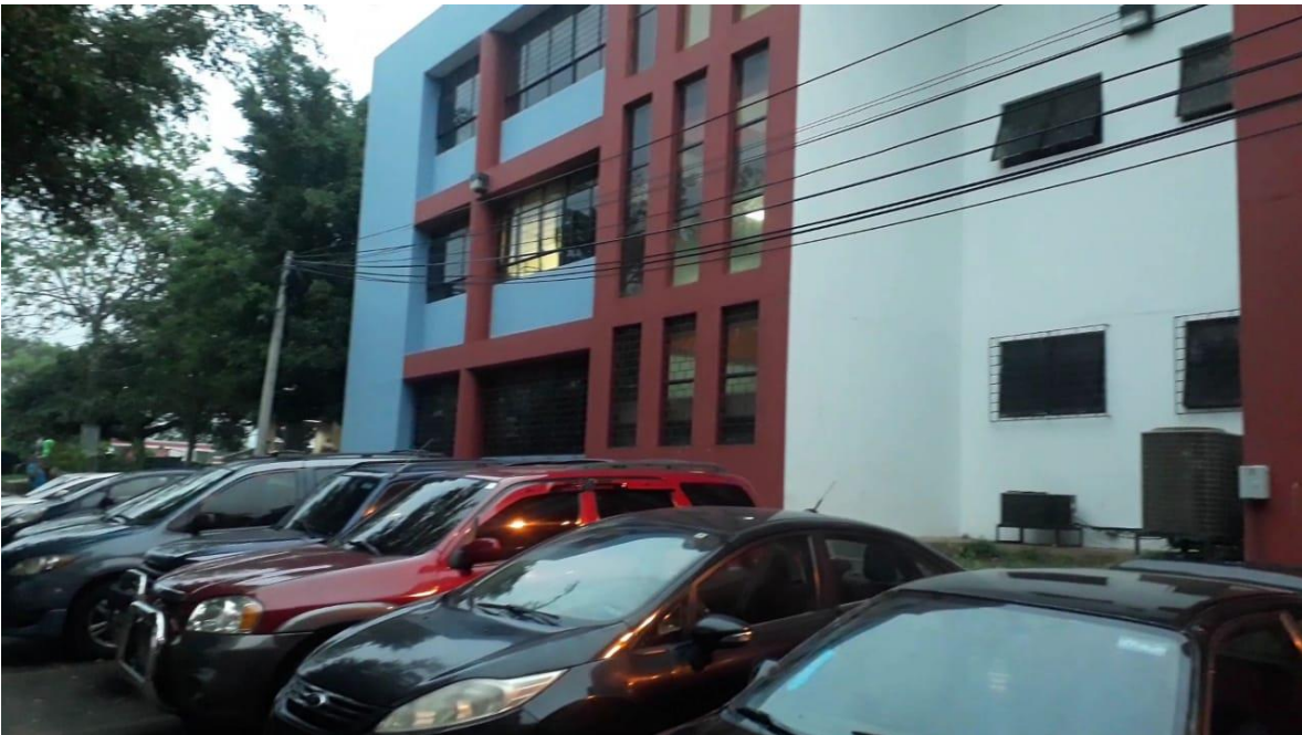
Anexo 2. Vista Sur del Edificio de Usos Múltiples de la Universidad de El Salvador, Facultad Multidisciplinaria de Occidente.
