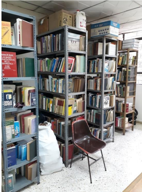
Figura 6. 4. Estantes no asegurados vulnerables a caídas ante un sismo.
