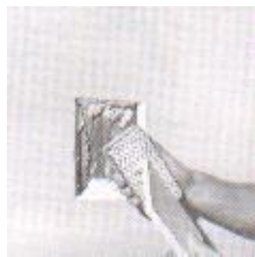
Fig. 101. Corte para reparación de pieza dañada Fig. 102. Colocación de pieza para cubrir tablero dañado.
