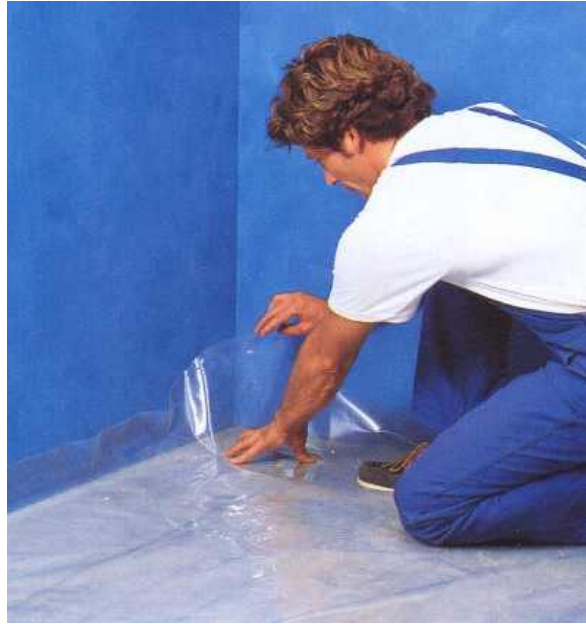
Fig. 89. Colocación de plástico protector contra la humedad.
