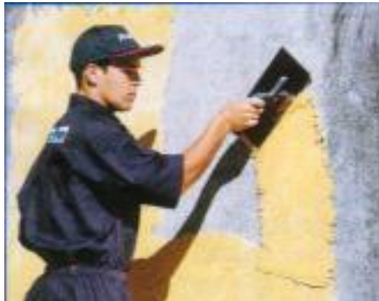
Fig. 194. Aplicación de repello con color.
