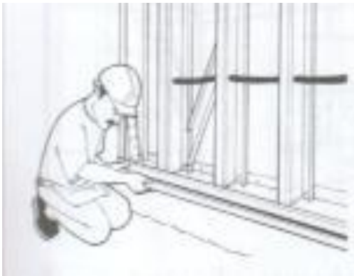
Fig.60. Colocación del botaguas.
