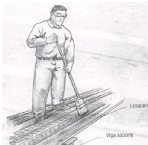
Fig. 145. Limpieza de la losacero previo al colado.
