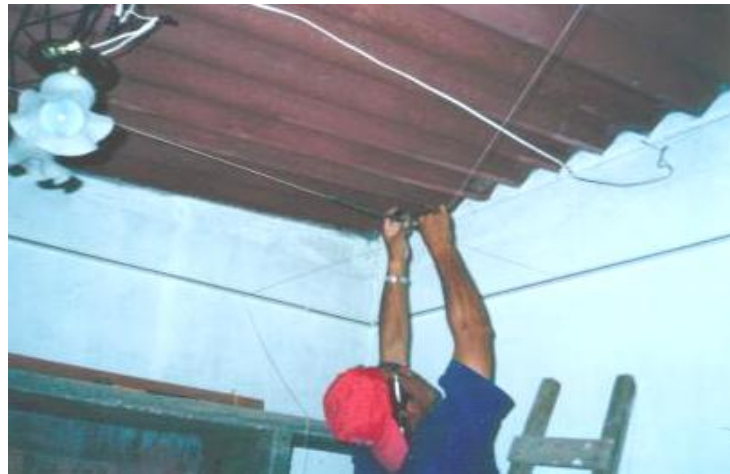
Fig. 108. Verificando escuadra del cordel.
