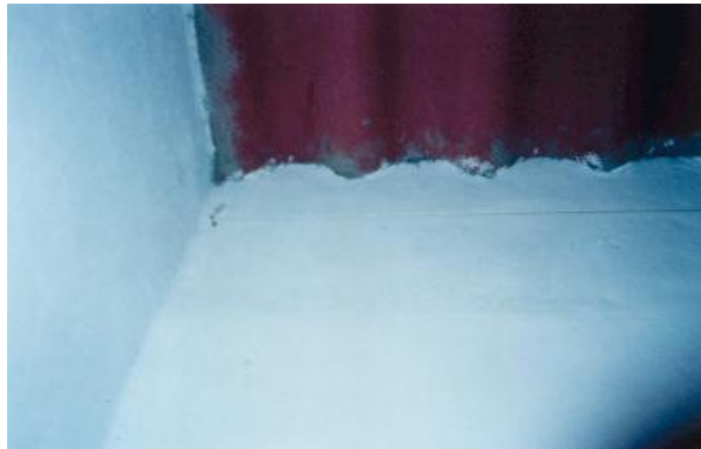
Fig. 106. Clavo y cordel para la nivelación.
