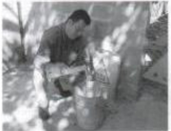
Fig. 233. Preparación de la pintura.
