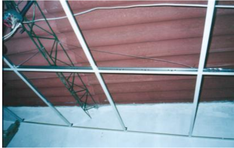
Fig. 110. Modulaci3n y fijaci3n con alambre galvanizado.
