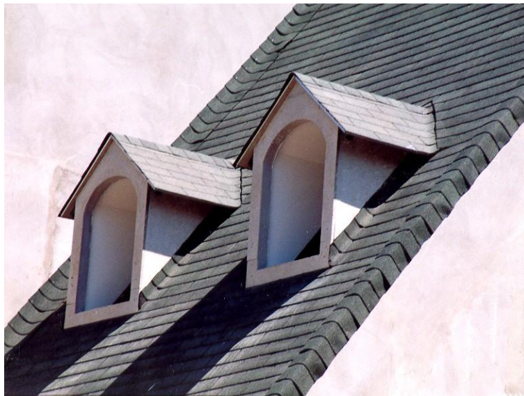
Fig. 189. Cubierta de una vivienda con teja asfáltica
