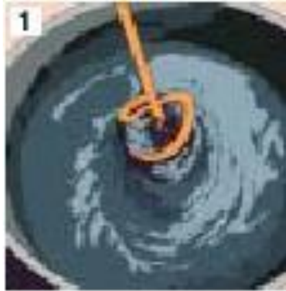
Fig. 78. Preparación de mezcla en un recipiente
