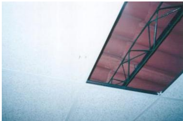
Fig.111. Instalaci3n de piezas de fibra de vidrio.
