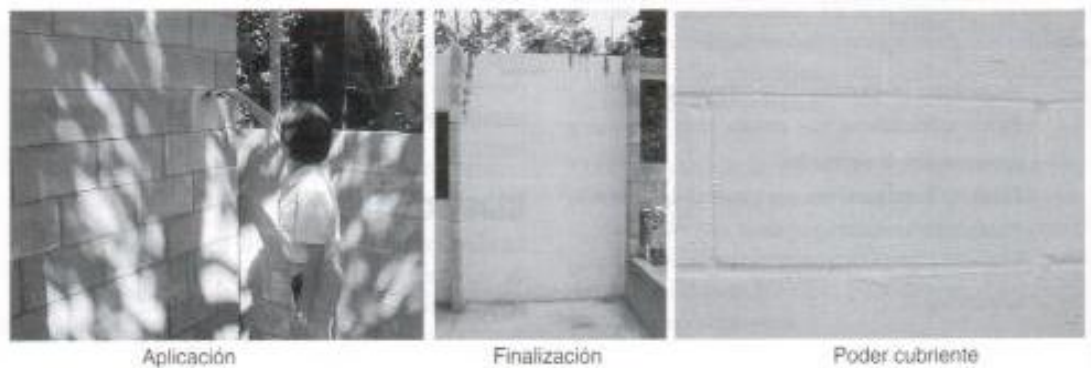
Fig. 234. Aplicación de la pintura
